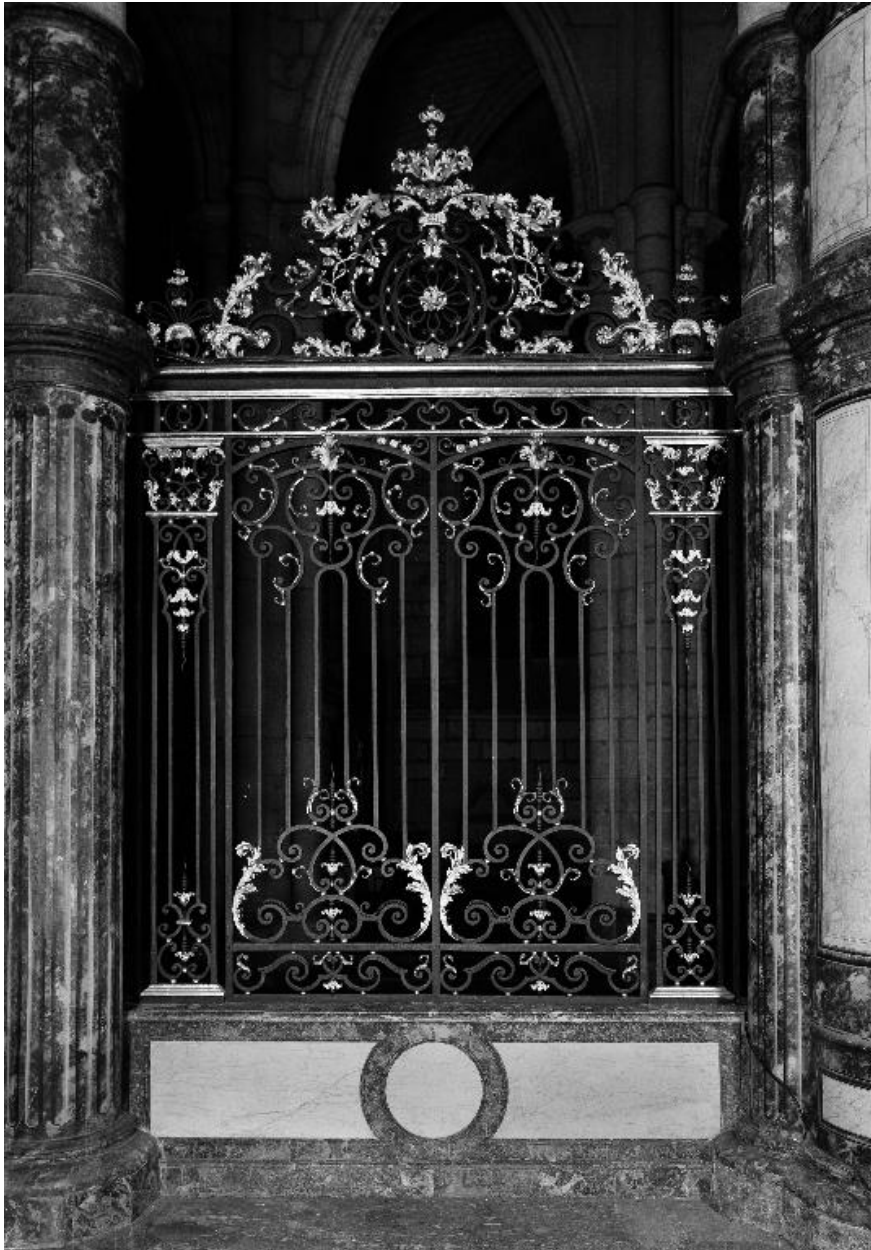
Vue d'une grille de la clôture de chœur.
