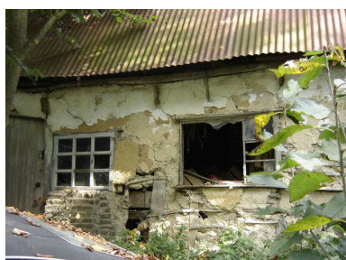
Vue des huisseries du bâtiment situé au sud. Phot. Inès Guérin IVR22_20078005316NUCA
