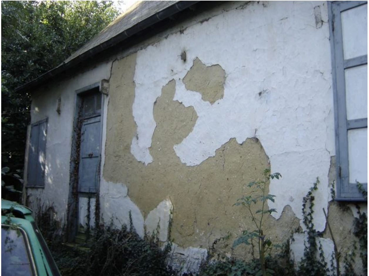
Détail des deux dernières travées.
