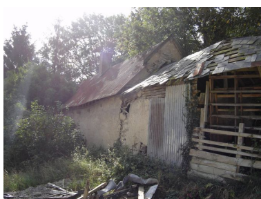
Vue postérieure du bâtiment situé au sud, avec rehaussement à l'aide d'un surcroît ajouré, prouvant que le bâtiment était auparavant couvert en chaume. Phot. Inès Guérin IVR22_20078005317NUCA
