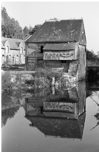
Vue du bâtiment d'eau, donnant sur le Noirieux. Phot. Christiane Riboulleau IVR22_19940201419Z
