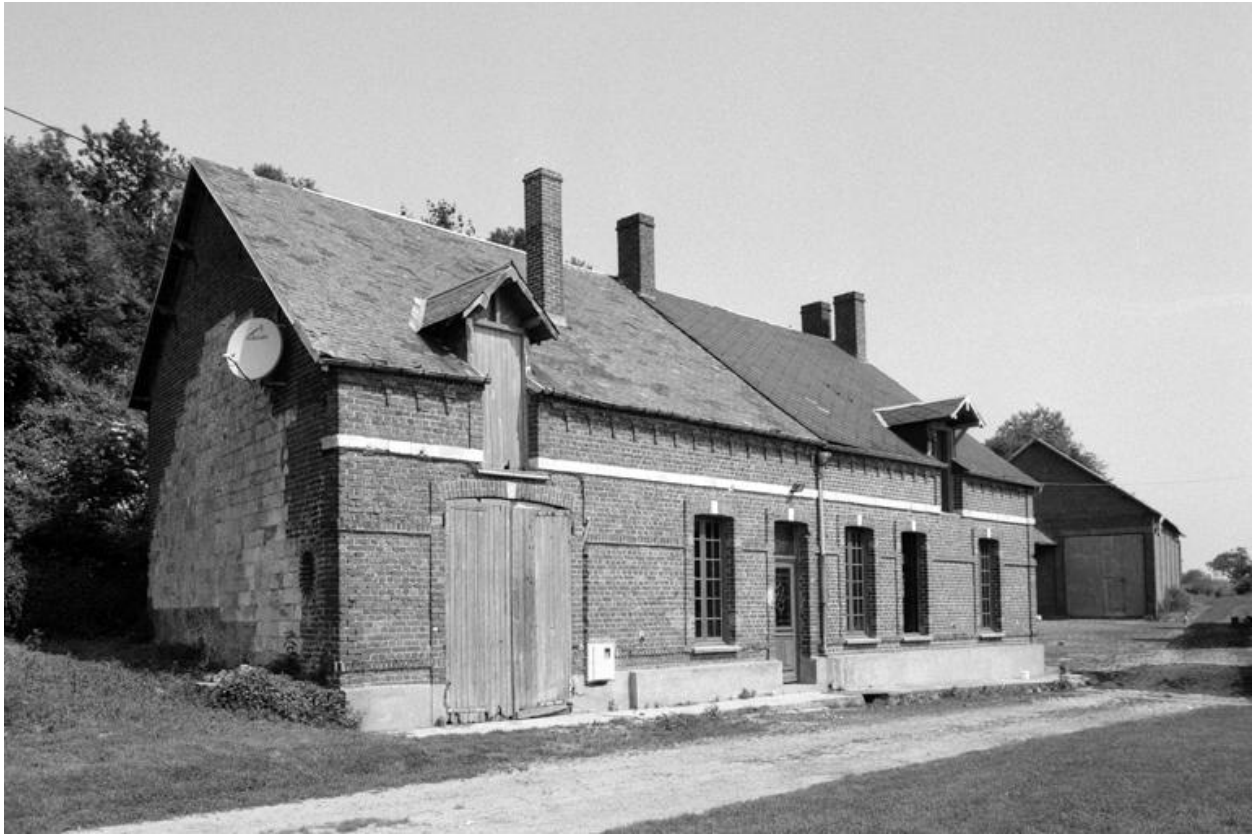
Vue du logis et de la remise attenante, depuis le sud.
