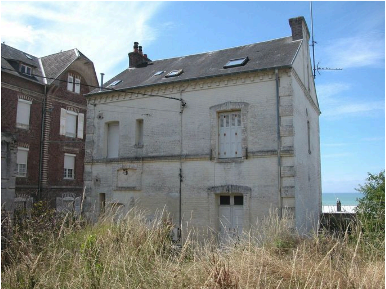
Elévation postérieure depuis la rue Gros.
