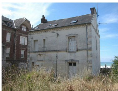
Elévation postérieure depuis la rue Gros. Phot. Elisabeth Justome IVR22_20048001539NUCA
