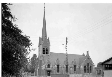
Élévation sud. Phot. Jean-Michel Perrin IVR22_19846001075X
