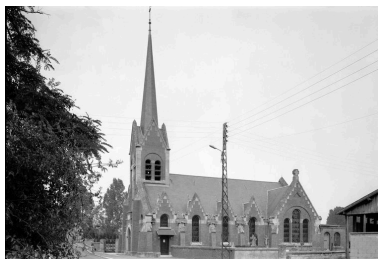
Élévation sud. Phot. Jean-Michel Perrin IVR22_19846001075X
