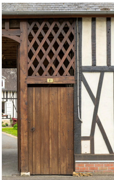
Porte piétonne avec imposte ajourée, n°51 rue de Beauvais, vue prise depuis le nord-ouest. Phot. Marc Kérignard IVR32_20236000693NUCA
