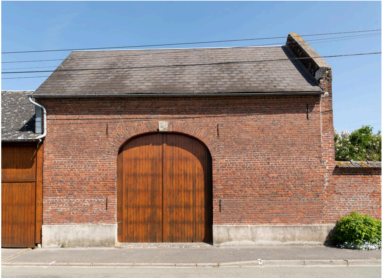
Ancienne grange, n°2 rue de l'Église, vue prise depuis le sud.
