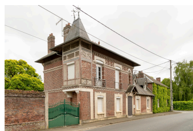
Ancienne maison de notable, n°8 rue de Provinlieu, vue prise depuis le nord. Phot. Marc Kérignard IVR32_20236000706NUCA
