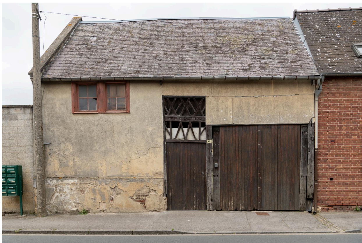
Ancienne grange sur rue avec entrée charretière et piétonne, n°46 rue de Beauvais, vue prise depuis l'est.
