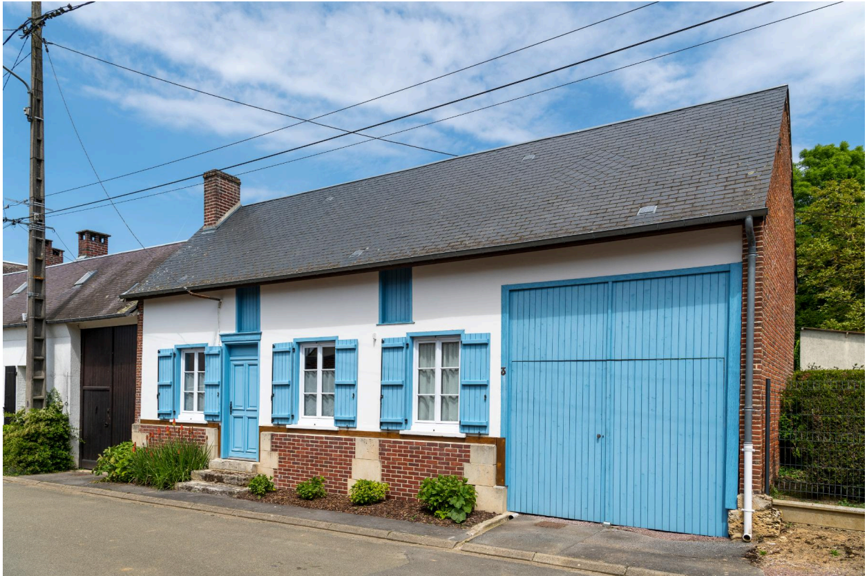
Logis sur rue avec entrée charretière, n°3 rue du Château, vue prise depuis le sud.
