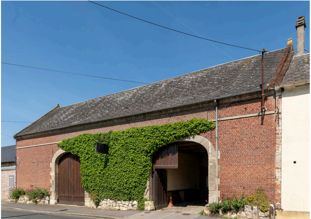
Grange sur rue, n°18 rue de Beauvais, vue prise depuis le sud-est.
