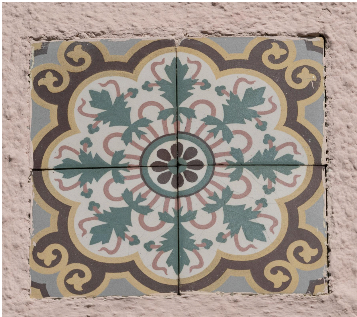
Décor en céramique sur la façade du n°7 rue de Provinlieu, vue prise depuis l'est.
