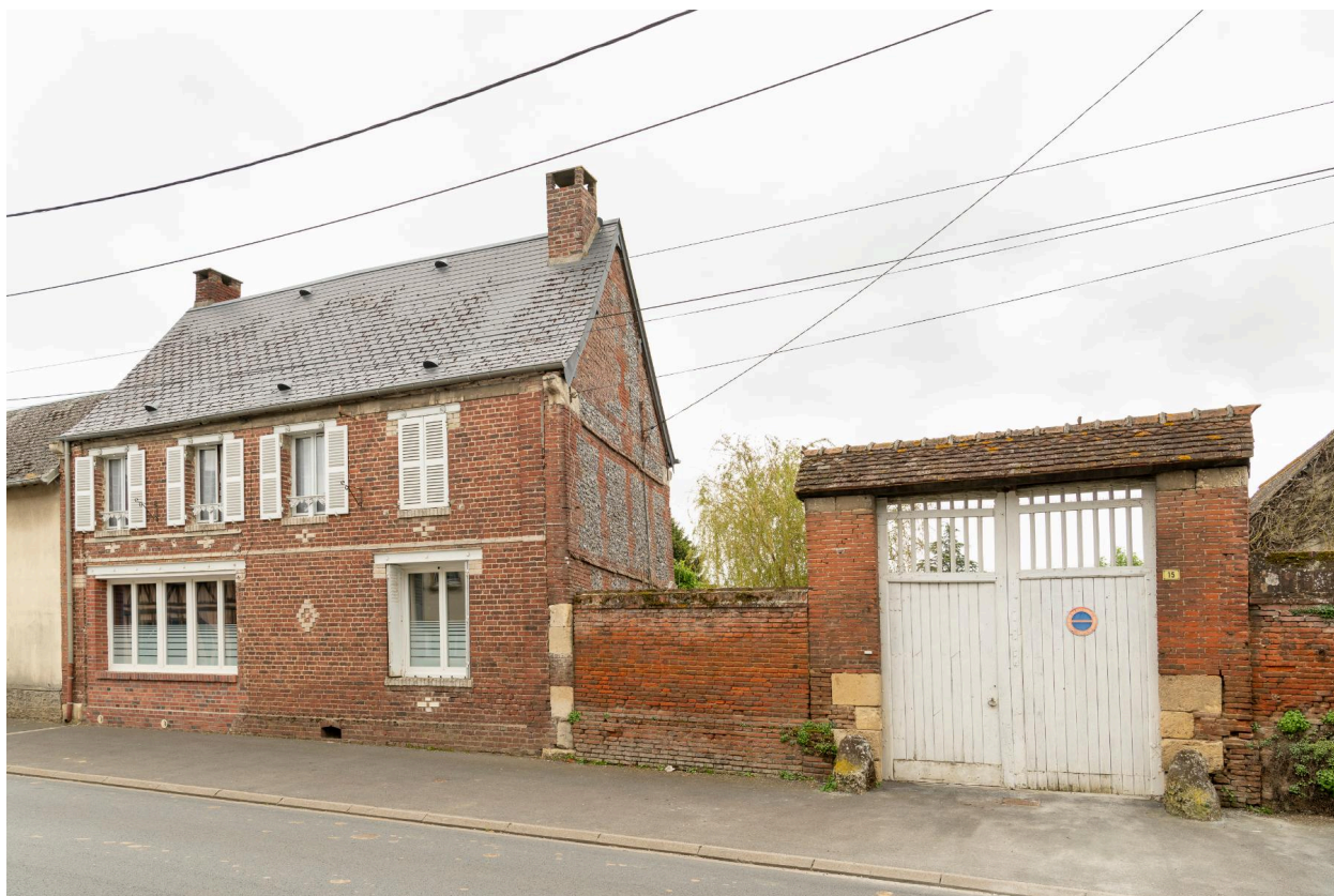
Ancienne épicerie, n°15 rue de Beauvais, vue prise depuis l'ouest.
