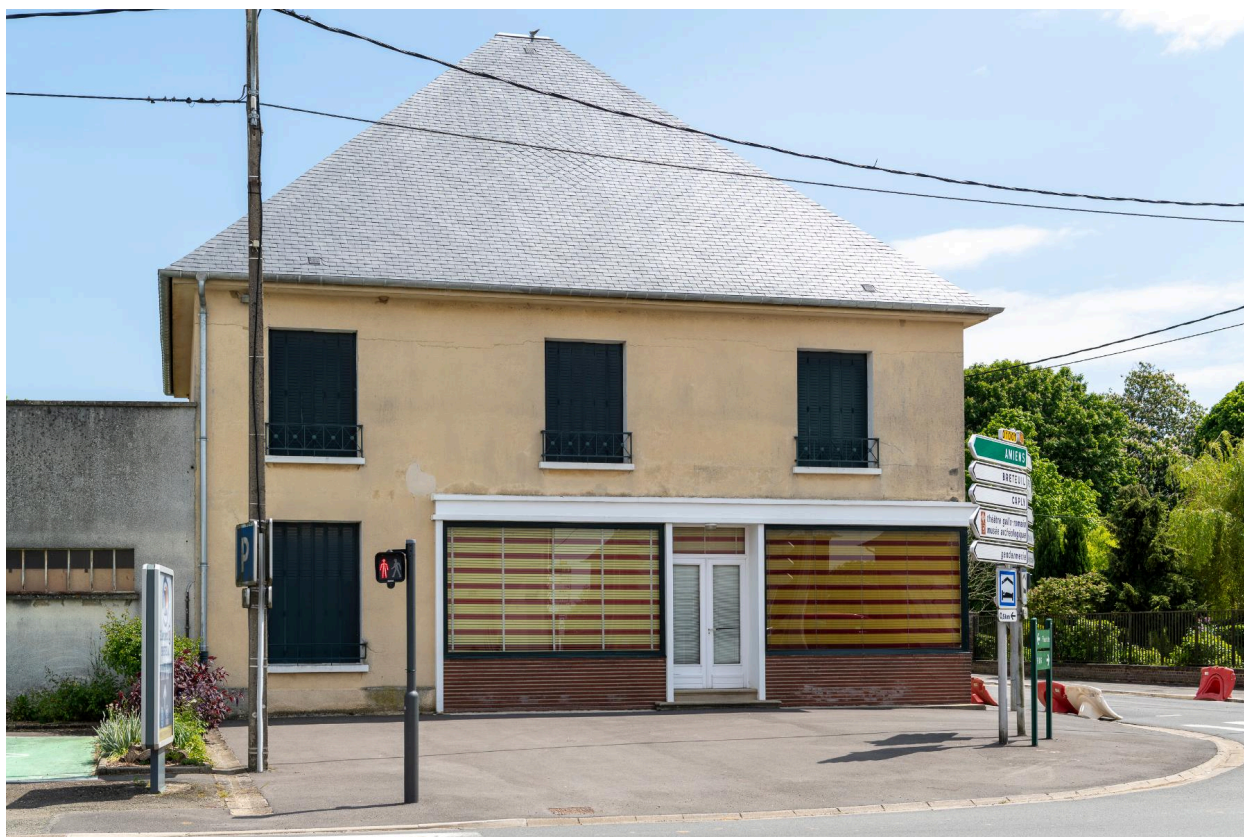
Ancien magasin de la famille Hua, aligné sur la rue de Provinlieu, n°1 rue du 8 mai 1945.
