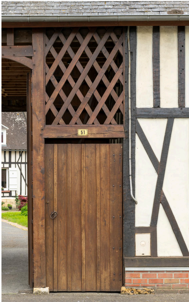
Porte piétonne avec imposte ajourée, n°51 rue de Beauvais, vue prise depuis le nord-ouest.
