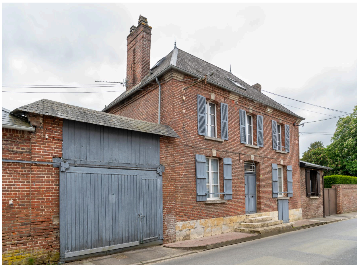
Ancienne maison de médecin (M. Sommaire), n°17 rue de l'Église, vue prise depuis le nord.
