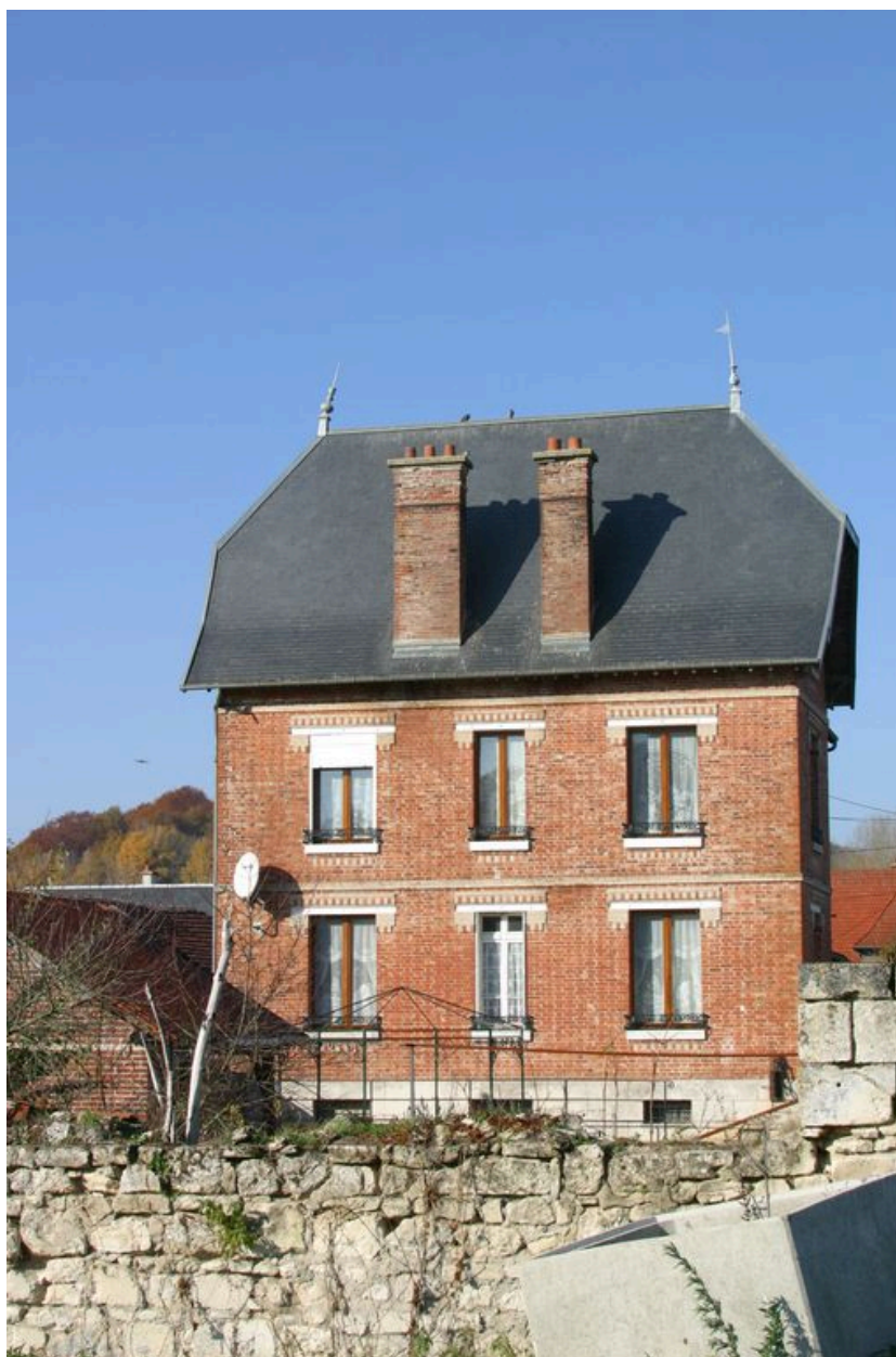
Vue générale de la façade postérieure.
