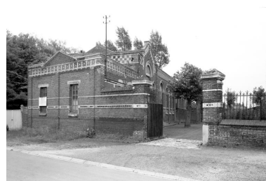
Salle paroissiale. Pignon et entrée de la cour. Phot. Jean-Michel Périn IVR31_19825900805X
