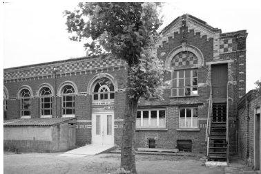
Détail de l'élévation sud de la salle paroissiale.. Phot. Jean-Michel Périn IVR31_19825900802X
