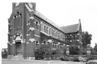
Vue latérale de la nef, vers le nord-est. Phot. Jean-Michel Périn IVR31_19825900808X
