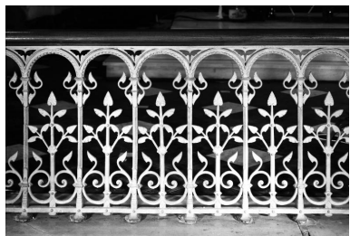
Grille de chœur. Phot. Jean-Michel Périn IVR31_19825900828X
