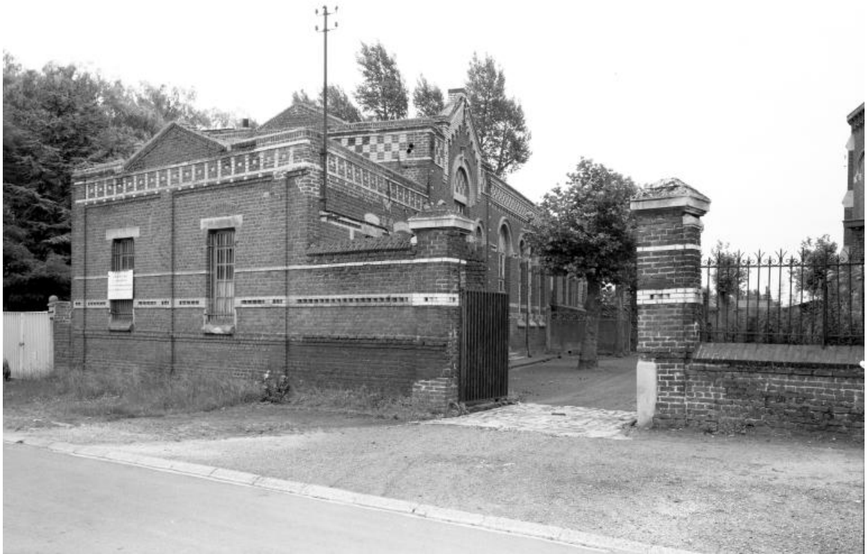
Salle paroissiale. Pignon et entrée de la cour.
