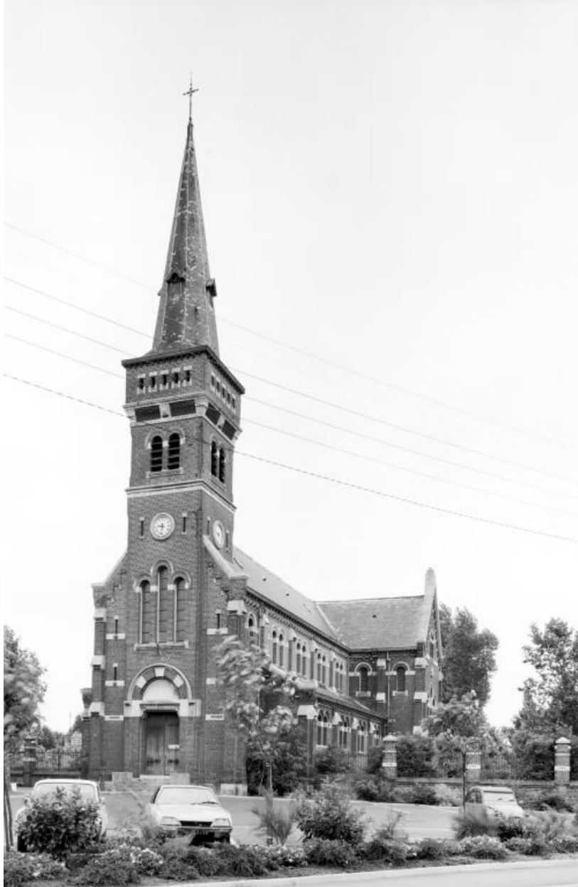
Vue de trois-quarts, vers le nord-est.
