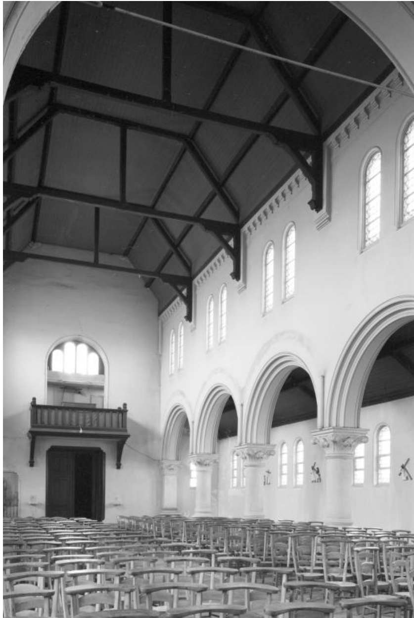
Vue intérieure, vers le nord-ouest.
