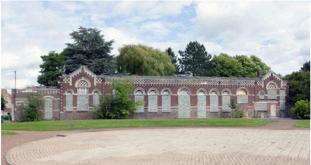
Élévation sud de la salle paroissiale transformée en chapelle Sainte-Barbe.
