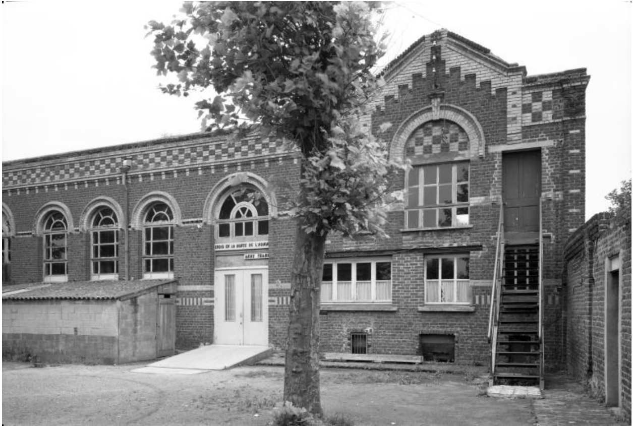
Détail de l'élévation sud de la salle paroissiale..
