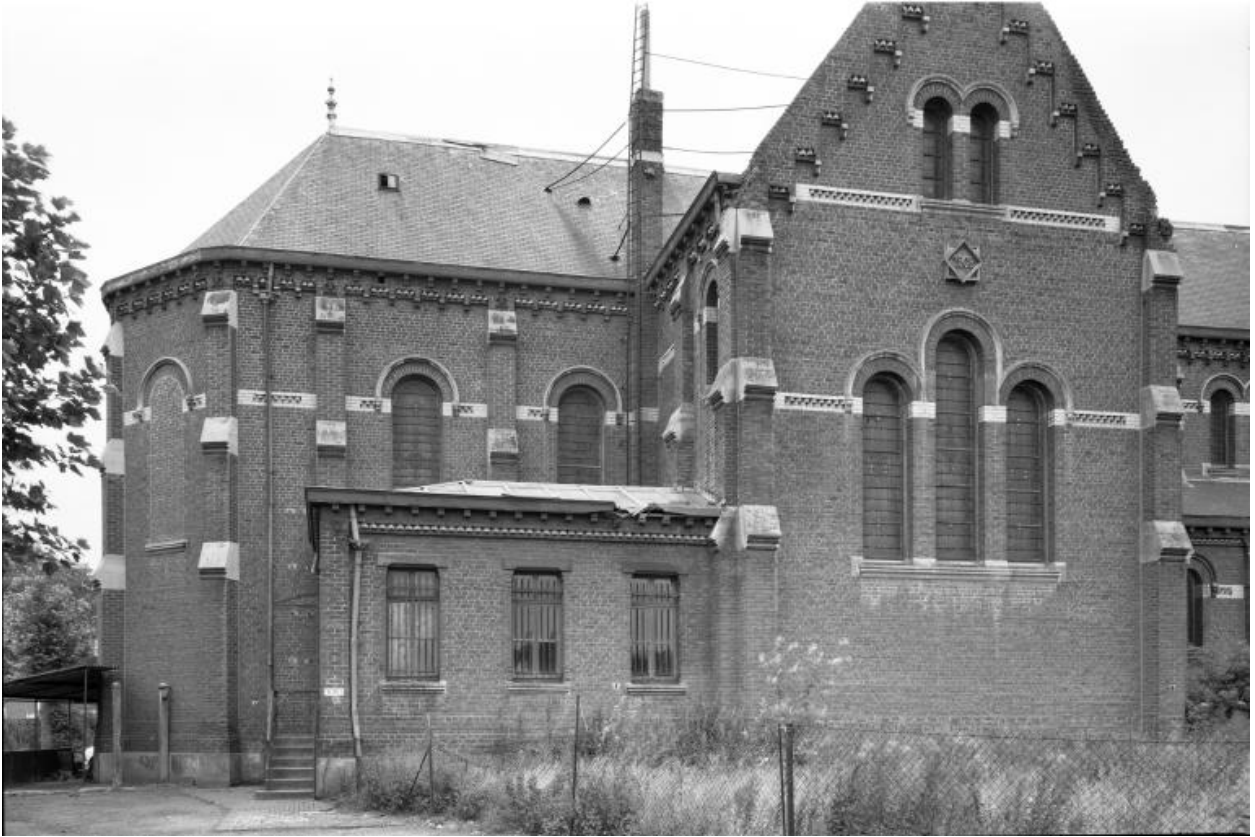
Vue du choeur et du transept, vers le sud.
