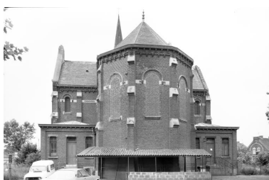
Vue du chevet, vers l'ouest. Phot. Jean-Michel Périn IVR31_19825900827X
