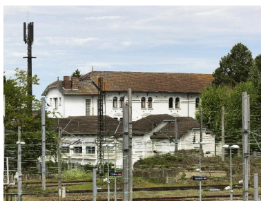
Vue de situation depuis la passerelle desservant les quais de la gare. Phot. Thierry Lefebure IVR32_20170200180NUC2A
