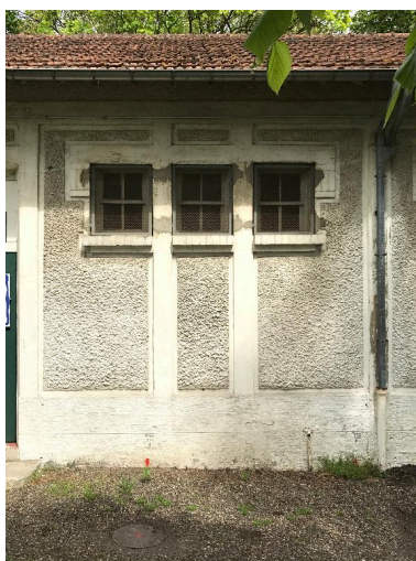
Détail d'une travée. Phot. Bertrand Fournier IVR32_20170205090NUC2A
