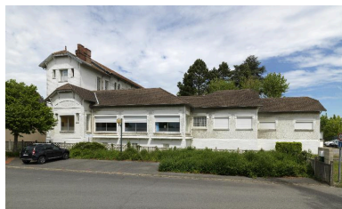
Le bâtiment abritant initialement, de gauche à droite, la salle de lecture, la cuisine et le réfectoire, les lavabos et les bains-douches. Vue de la façade sud sur la rue. Phot. Thierry Lefébure IVR32_20170200182NUC2A
