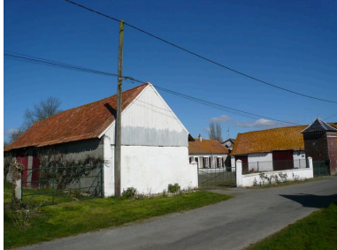
Vue d'ensemble. Phot. Inès Guérin IVR22_20078005745NUCA
