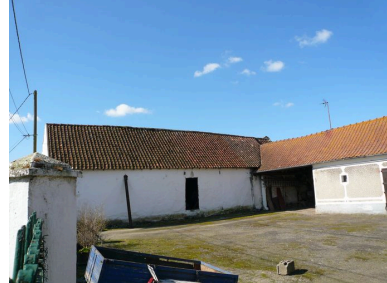
Vue de la grange. Phot. Inès Guérin IVR22_20078005747NUCA
