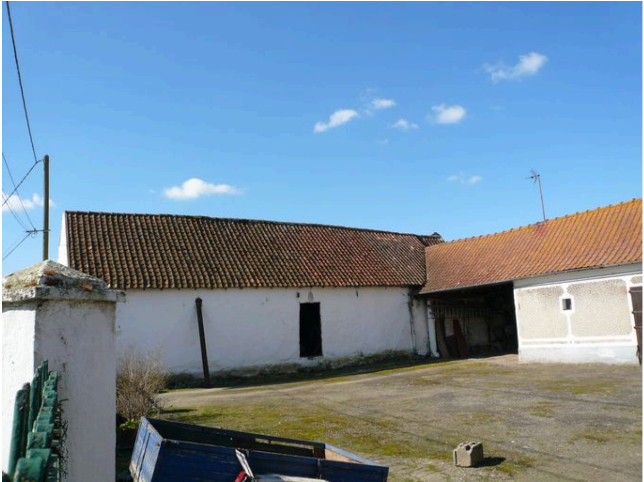
Vue de la grange.
