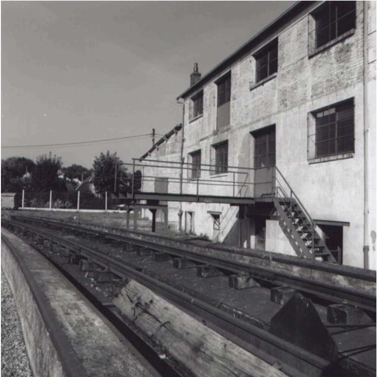
Le quai de chargement et l'embranchement ferroviaire.
