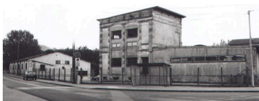
Vue d'ensemble sur rue. Phot. Thierry Lefébure IVR22_20026000989X
