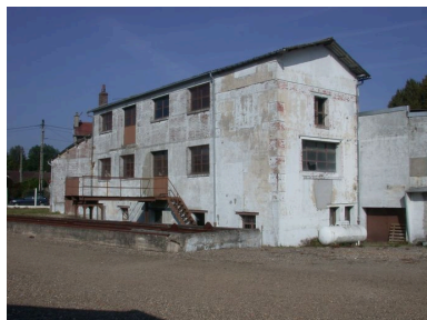
Atelier de fabrication. Phot. Thierry Lefébure IVR22_20026000865NUCA
