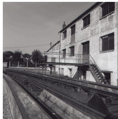
Le quai de chargement et l'embranchement ferroviaire. Phot. Thierry Lefébure IVR22_20026000847X
