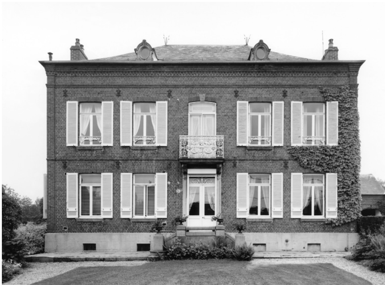
Façade du logis portant la date de 1880.
