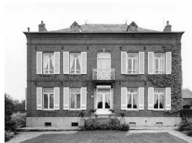
Façade du logis portant la date de 1880.
