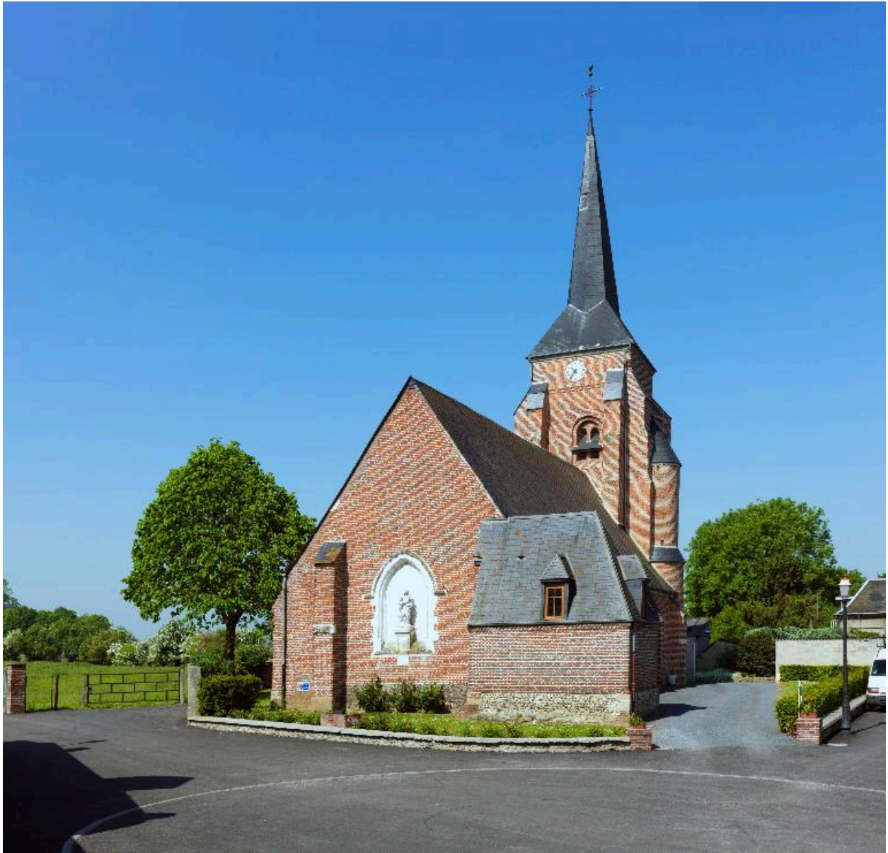
Vue générale depuis la place du Maréchal Leclerc.
