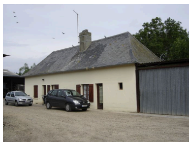
Vue du logis depuis la cour. Phot. Inès Guérin IVR22_20058006067NUCA
