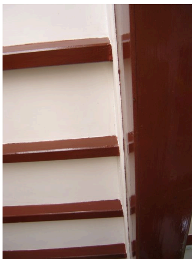
Vue des poutres et solives de la salle. Phot. Inès Guérin IVR22_20058006069NUCA
