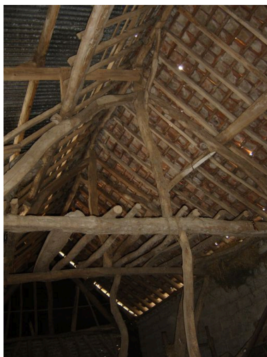
Vue de la charpente de la grange. Phot. Inès Guérin IVR22_20058006073NUCA
