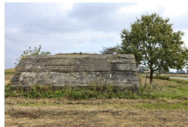
Elévation ouest Phot. Jean-Marc Ramette IVR31_20155904752NUCA
