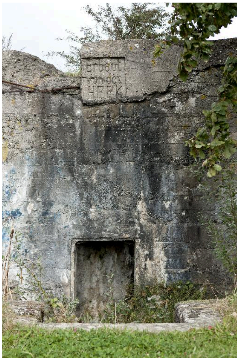
Détail de la travée centrale. L'entrée surmontée de son macaron
