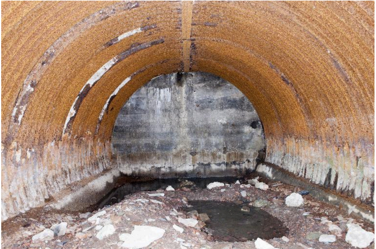
Une des deux salles de l'abri, depuis le couloir
