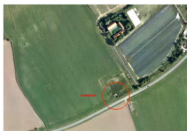
Position de l'édifice sur une vue aérienne de 2009 Phot. Jean-Marc Ramette IVR32_20175900508NUCA
