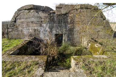
Elévation sud. Détail de la cour Phot. Jean-Marc Ramette IVR32_20175900505NUCA
