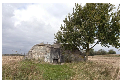
Elévation sud, depuis la R.D. 141 Phot. Jean-Marc Ramette IVR31_20155904749NUCA
