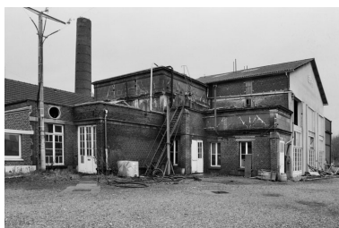
La chaufferie et la cheminée vues du sud-est. Phot. Benoît Dufournier IVR22_19878000486Z
