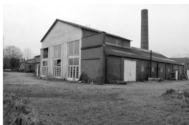
Chaufferie et cheminée, élévation sud est. Phot. Benoît Dufournier IVR22_19878000484Z
