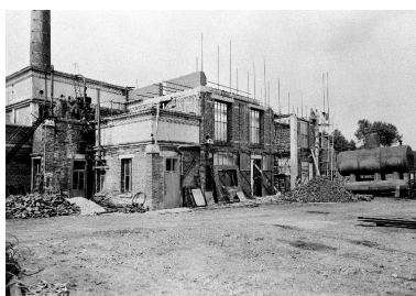
La chaufferie en cours de reconstruction. Juillet 1953 (coll. part.). Phot. Philippot Jacques IVR22_19878000264XB
