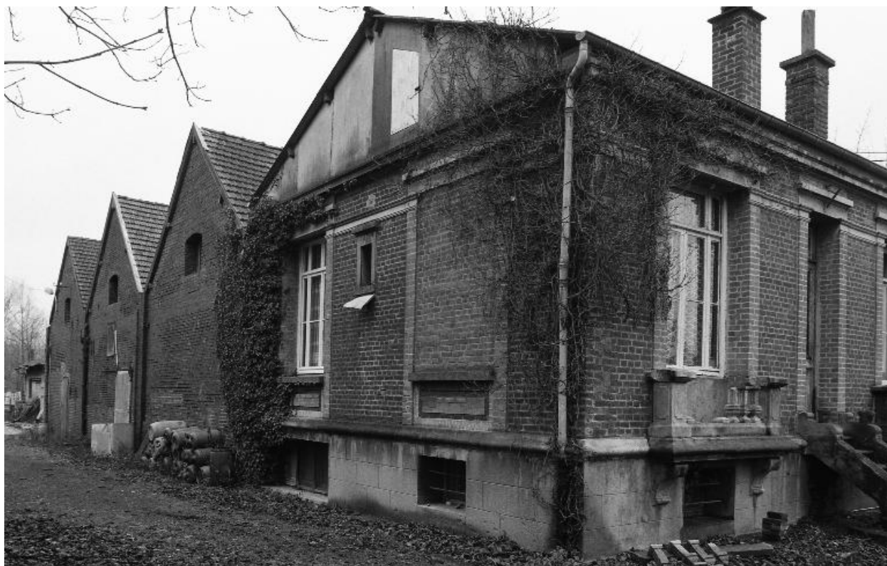
Conciergerie et atelier de fabrication, flanc sud-ouest.
