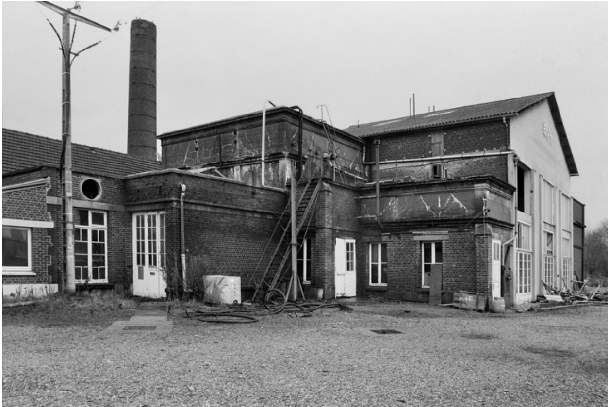
La chaufferie et la cheminée vues du sud-est.
