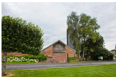
Vue coté ouest. Phot. Hubert Bouvet IVR31_20156200330NUCA
