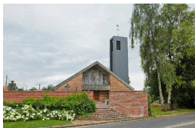
Vue coté ouest. Phot. Hubert Bouvet IVR31_20156200331NUCA
