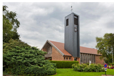
Vue 3/4 sud. Phot. Hubert Bouvet IVR31_20156200329NUCA
