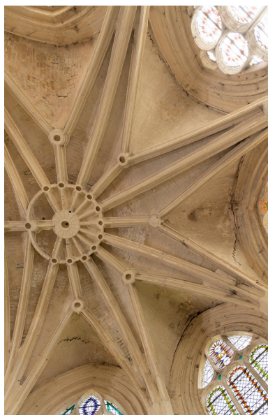
Voûtes du sanctuaire. Phot. Marc Kérignard IVR32_20236000460NUCA
