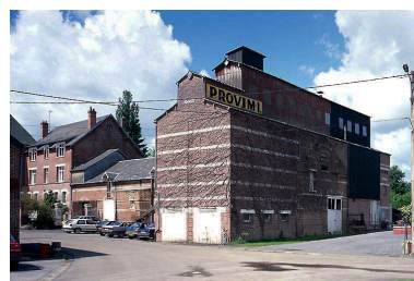
Vue générale. Phot. Laurent Jumel IVR22_19980201262XA
