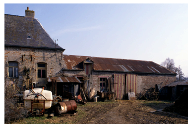
Remise à l'est de la cour, servant d'écurie. Phot. Christiane Riboulleau IVR22_19960200170ZA
