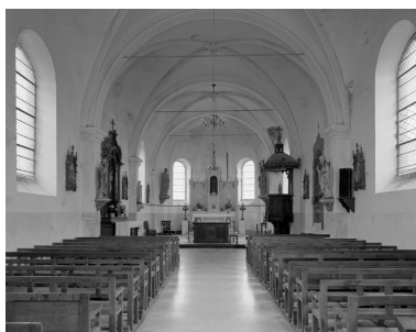
Vue intérieure de l'église, vers le chœur. Phot. Thierry Lefébure IVR22_19930200556V
