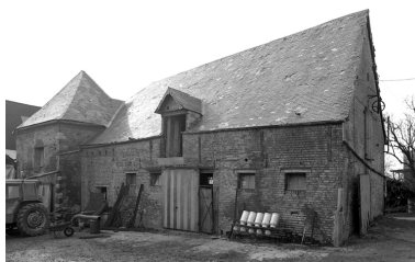
Etable, à l'ouest de la cour. Phot. Christiane Riboulleau IVR22_19960200376Z
