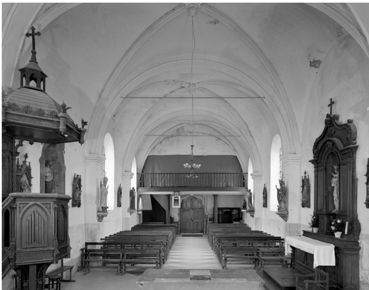
Vue intérieure de l'église, vers l'entrée.
