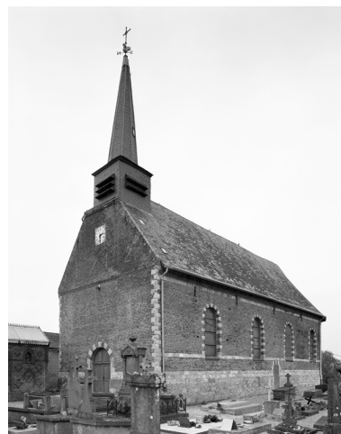
Eglise priorale, actuellement église paroissiale Saint-Pierre et Saint-Paul : vue de trois-quarts ouest. Phot. Thierry Lefébure IVR22_19930200610V
