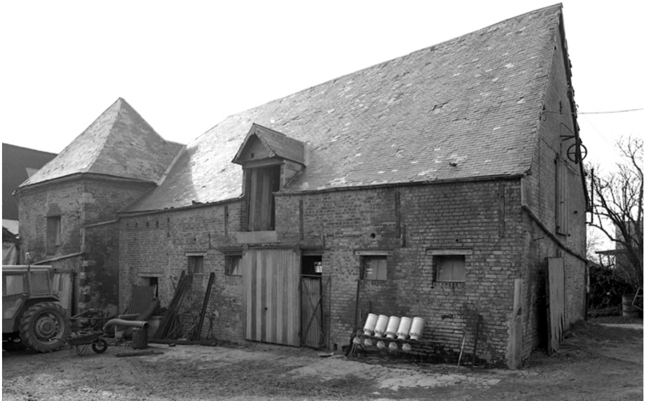
Etable, à l'ouest de la cour.
