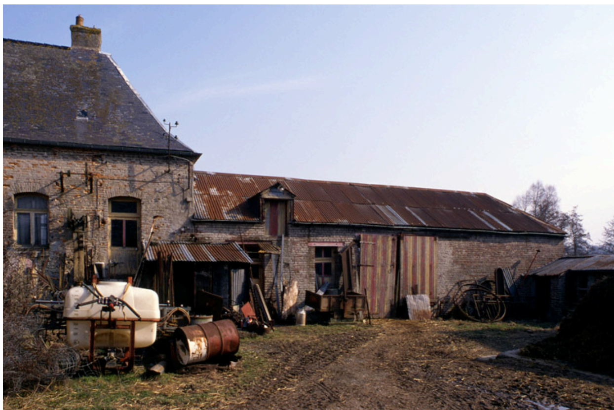
Remise à l'est de la cour, servant d'écurie.
