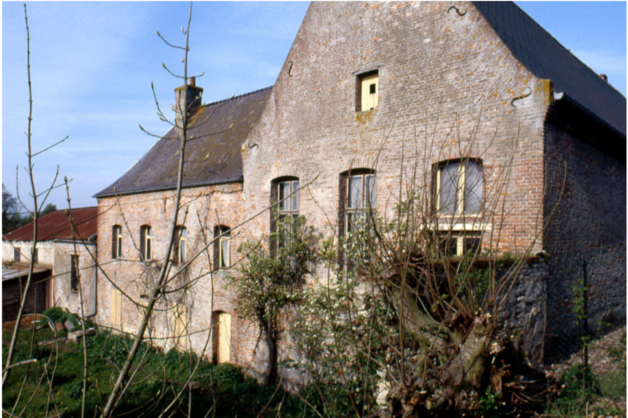
Elévations externes du logis prioral.
