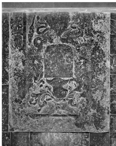
Vue de la partie visible de la dalle.
