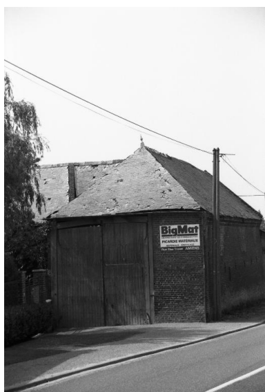
Passage charretier de la grange ouvrant sur la route d'Amiens à Contay. Phot. Judith Förstel IVR22_20018000293Z
