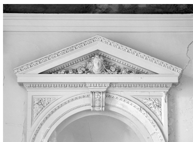
Fronton de la niche de l'escalier. Phot. Jean-Michel Périn IVR31_19886200601X
