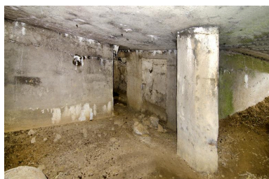
Entrée en chicane et salle sud (au très grand angulaire) Phot. Jean-Marc Ramette IVR31_20145905035NUCA
