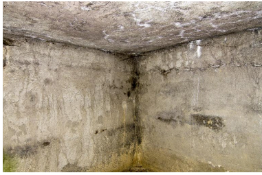
Salle nord, l'angle sud-ouest (au très grand angulaire) Phot. Jean-Marc Ramette IVR31_20145905042NUCA
