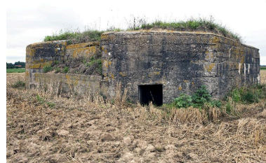
Vue de trois-quarts vers le sud-ouest. Entrée nord Phot. Pierre Thibaut IVR31_20155901446NUCA
