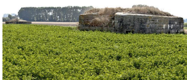
Vue générale vers le sud-ouest. A l'arrière plan une autre casemate à mitrailleuse (IA59004903) Phot. Jean-Marc Ramette IVR31_20145905044NUCA
