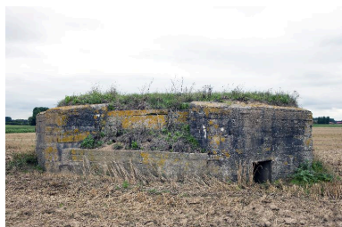
Vue antérieure, vers l'est. Au centre, la banquette de tir Phot. Pierre Thibaut IVR31_20155901445NUCA
