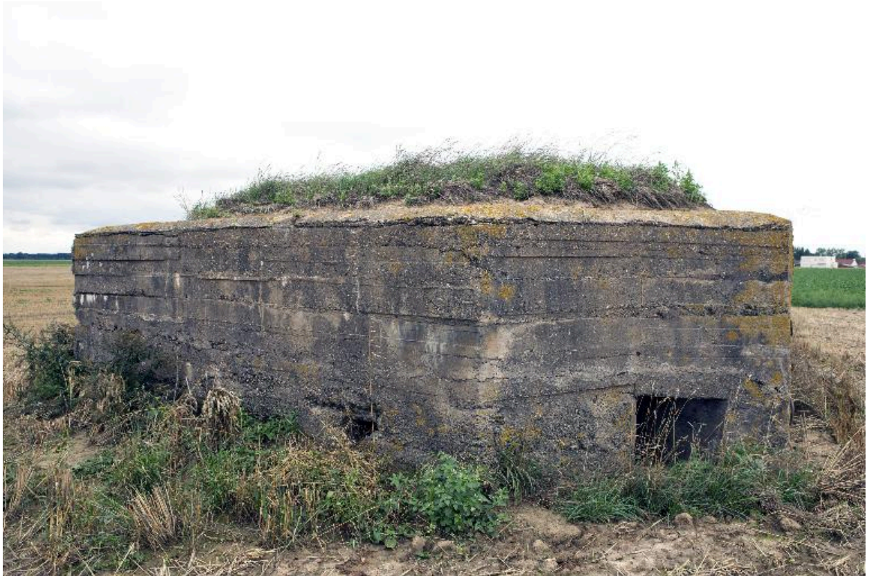
Vue latérale sud, vers le nord-est
