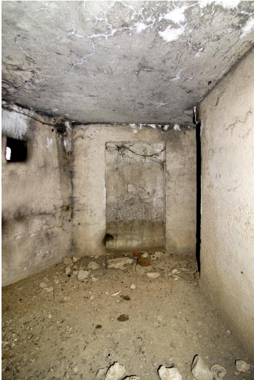
Niche de la salle nord. A gauche le créneau de fusillade de l'entrée en chicane (au très grand angulaire)
