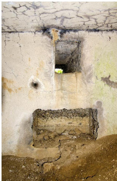
Salle nord. Créneau de fusillade de l'élévation nord (au très grand angulaire) Phot. Jean-Marc Ramette IVR31_20145905037NUCA
