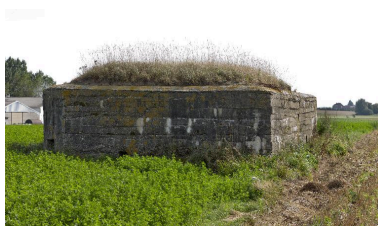
Vue latérale nord, vers le sud-ouest
