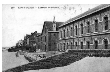
Élévation antérieure donnant sur la mer, vue en enfilade prise depuis le flanc sud de la terrasse aménagée au-devant des bâtiments. Carte postale, 1er quart du 20e siècle (coll. part.). Phot. Thibaut Pierre (reproduction) IVR31_20066200127NUCB
