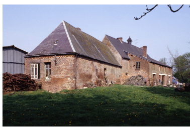
Vue de l'élévation postérieure du logis, depuis le sud-est. Phot. Christiane Riboulleau IVR22_19930201185ZA
