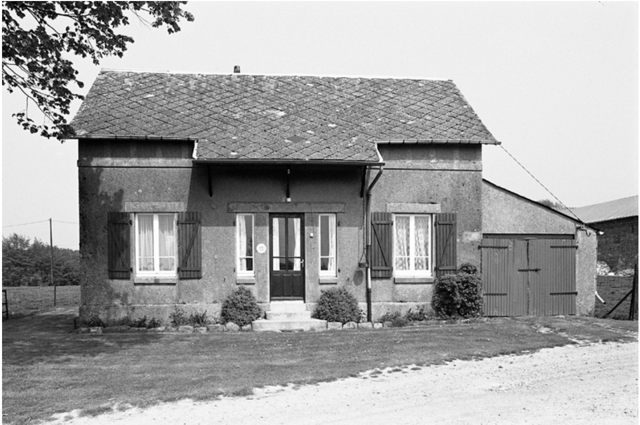
Façade d'un logement rattaché à l'exploitation agricole.
