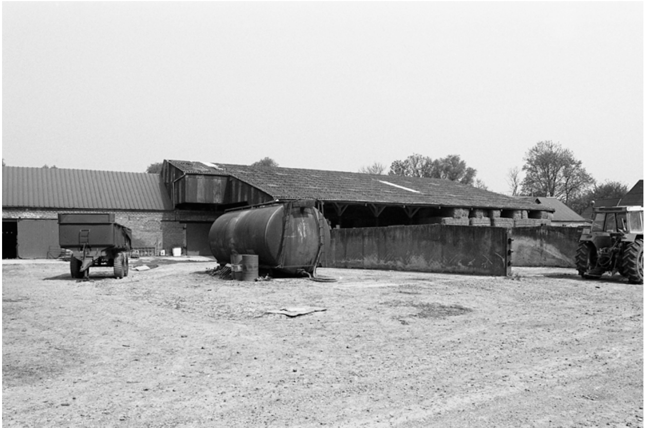
Vue de l'élévation sur cour des étables nord, accrues d'un hangar.
