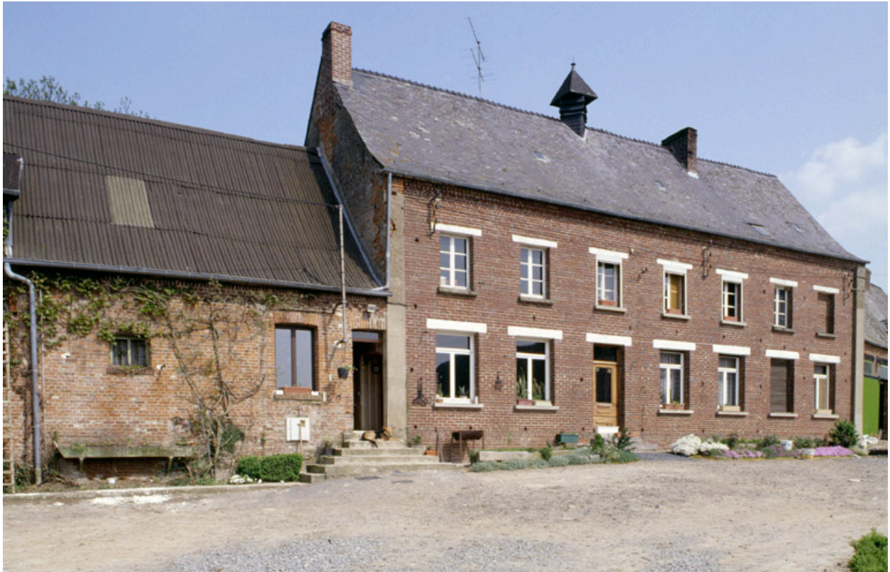
Vue du logis, depuis le sud-est.
