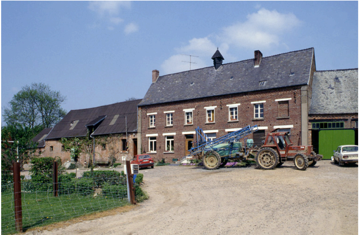
Vue d'ensemble du logis, depuis le sud-ouest.
