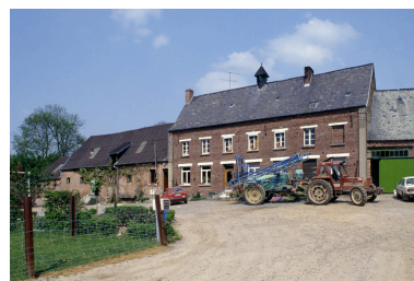
Vue d'ensemble du logis, depuis le sud-ouest. Phot. Christiane Riboulleau IVR22_19930201187ZA
