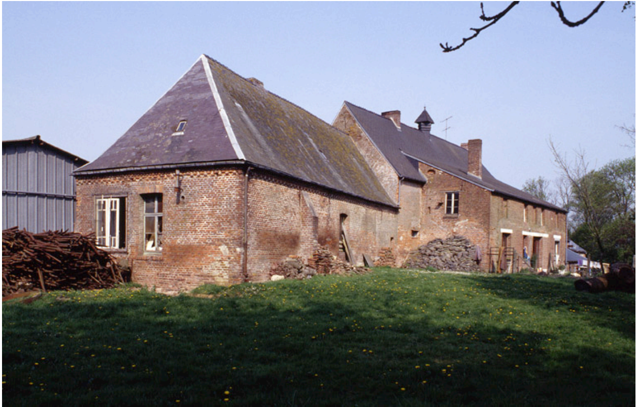
Vue de l'élévation postérieure du logis, depuis le sud-est.
