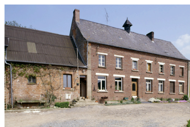
Vue du logis, depuis le sud-est. Phot. Christiane Riboulleau IVR22_19930201188ZA
