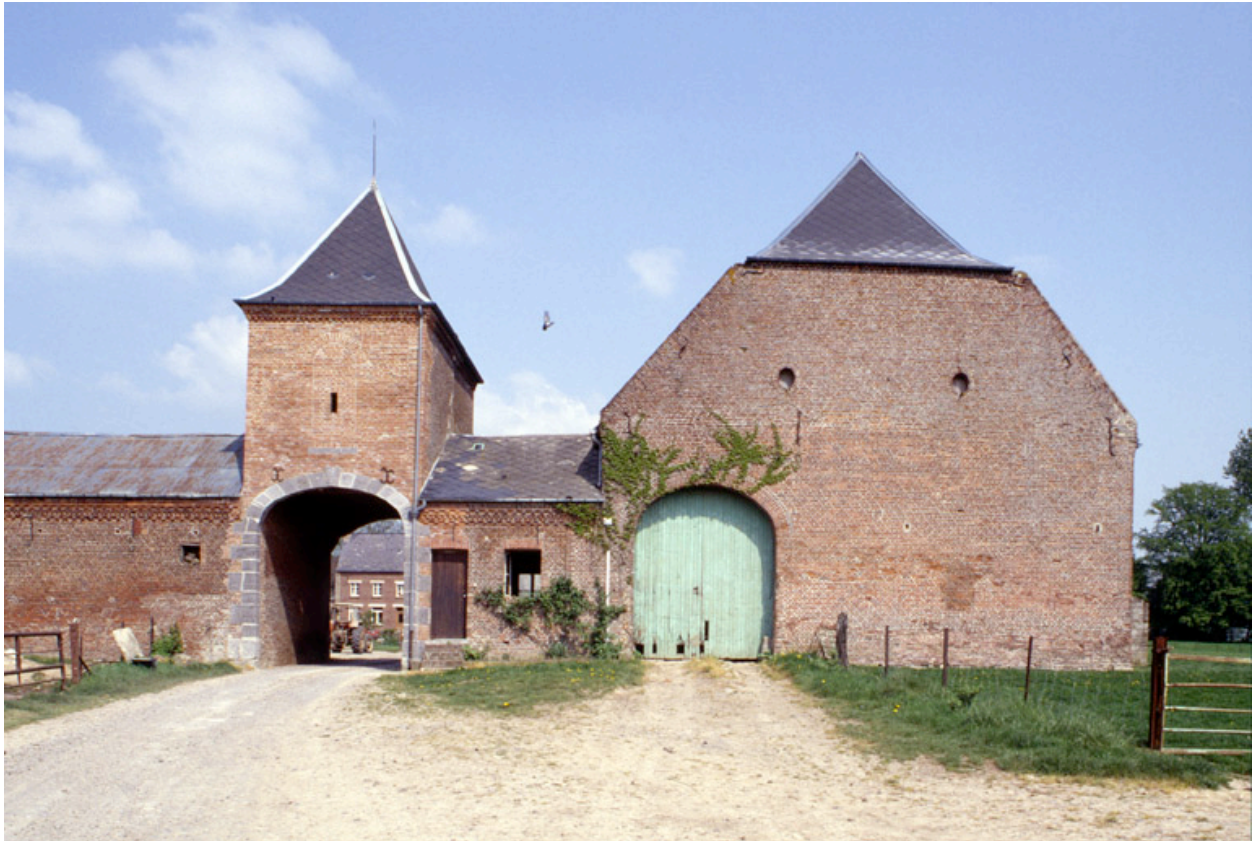
Vue du pigeonnier-porche avec la grange attenante, depuis l'ouest.
