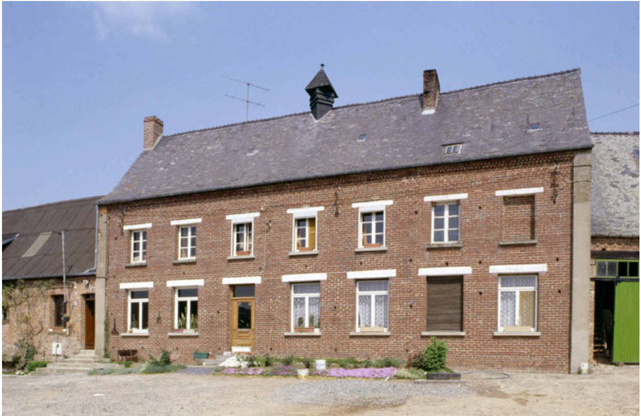
Vue générale de la façade du logis.
