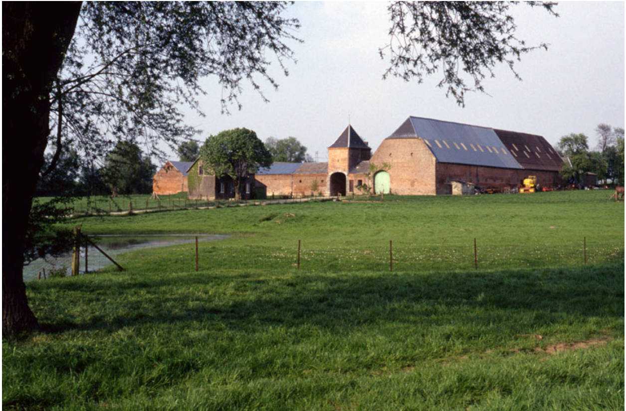
Vue d'ensemble sud-ouest.
