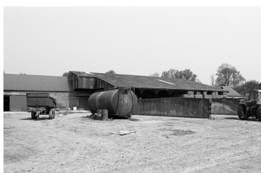
Vue de l'élévation sur cour des étables nord, accrues d'un hangar. Phot. Christiane Riboulleau IVR22_19940201997Z
