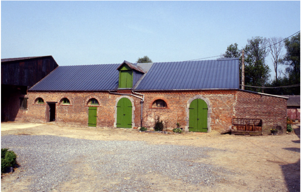
Vue partielle de l'élévation sur cour des étables nord.
