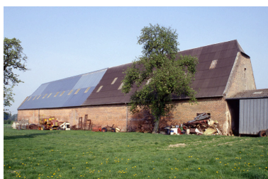
Vue d'ensemble sud-est de la grange. Phot. Christiane Riboulleau IVR22_19930201184ZA
