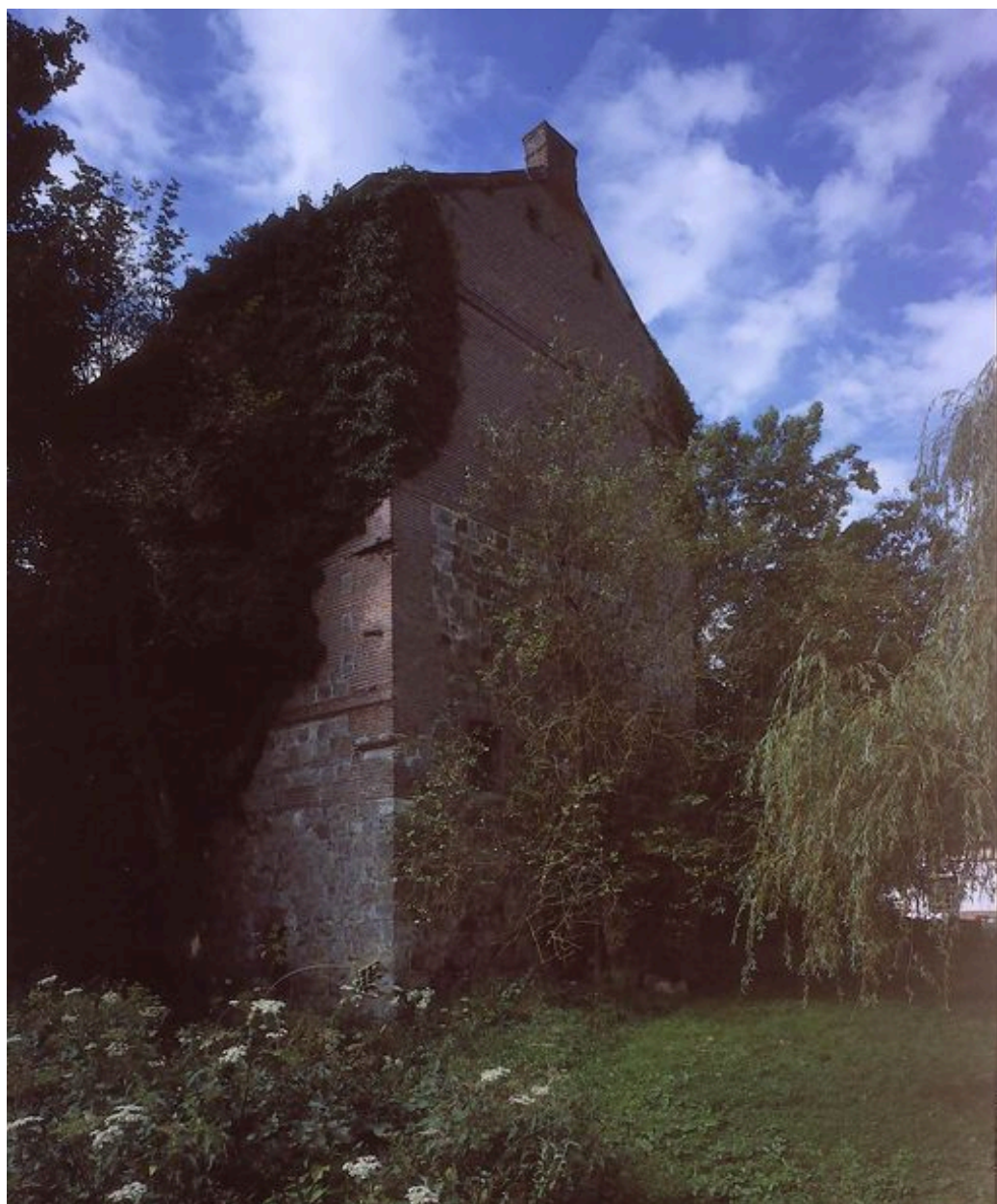
Pignon sur cour du moulin, vue d'ensemble.
