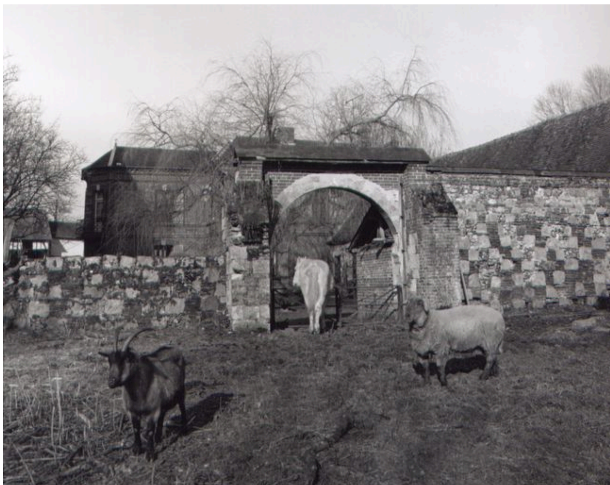
Le mur de clôture.
