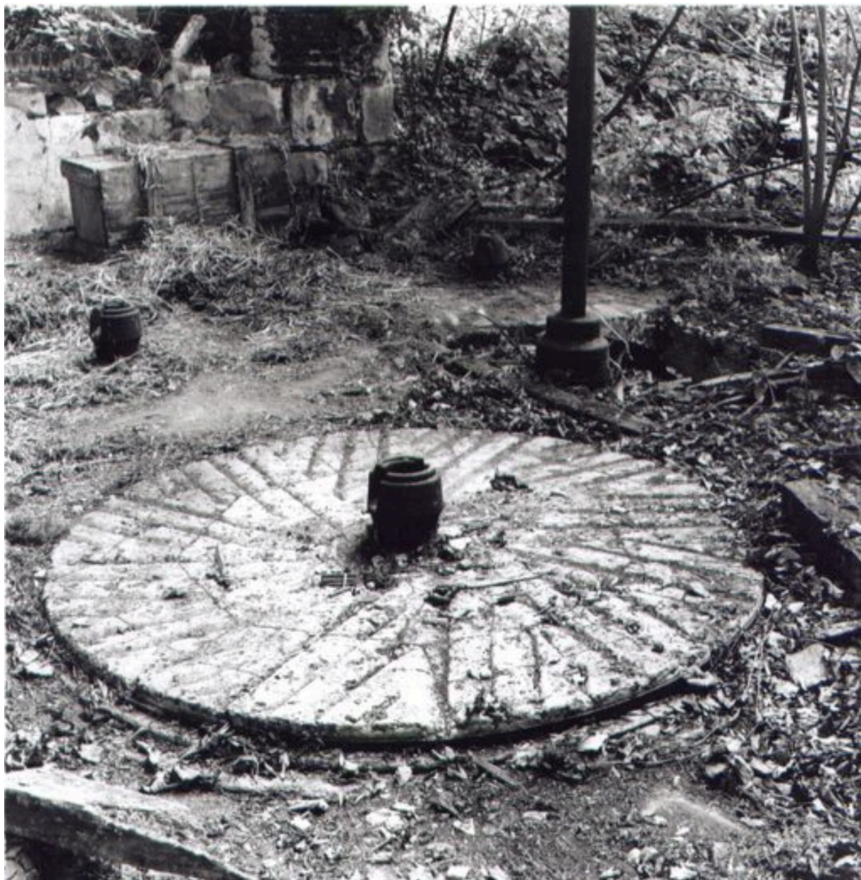
Détail d'une des meules depuis le rez-de-chaussée.
