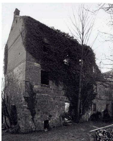
Elévation nord du moulin, vue d'ensemble. Phot. Thierry Lefébure IVR22_20036000013X
