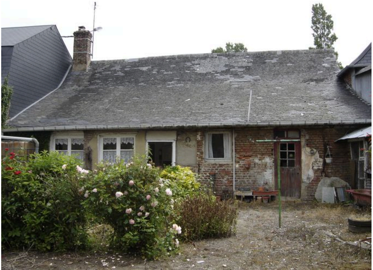
Vue postérieure depuis la cour intérieure.
