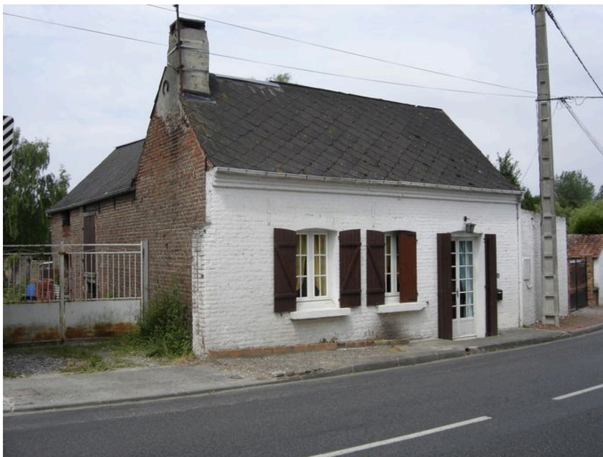
Vue des anciennes dépendances converties en logis, situé au n°144 route de Gamaches.
