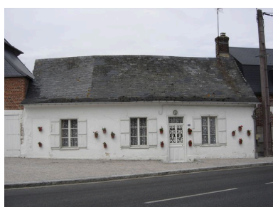
Vue du logis en torchis. Phot. Inès Guérin IVR22_20058006088NUCA
