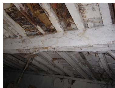
Vue du plafond des écuries. Phot. Inès Guérin IVR22_20058006096NUCA
