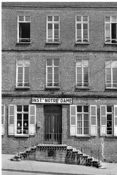
Vue de la façade sur rue. Phot. Pierre-Yves Brest IVR22_19990202050Z
