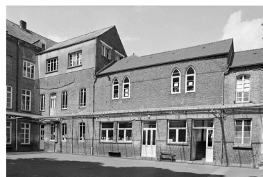
Vue de l'ancien préau surmonté de la chapelle (élevé dans la 2e moitié du 19e siècle). Phot. Pierre-Yves Brest IVR22_19990201847Z
