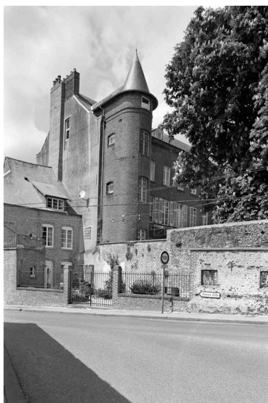
Vue de l'escalier hors-oeuvre, élevé sur la façade postérieure. Phot. Pierre-Yves Brest IVR22_19990202049Z
