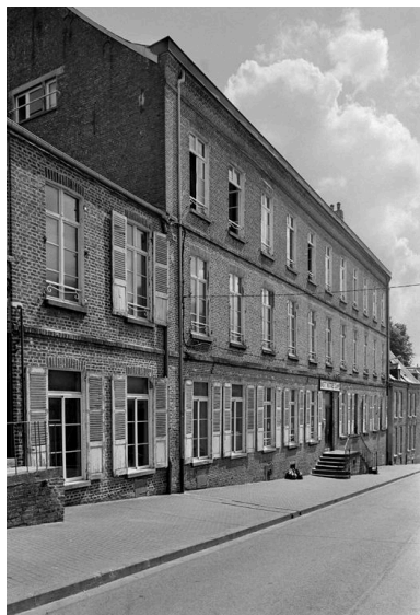
Vue de la façade sur rue. Phot. Pierre-Yves Brest IVR22_19990201849Z
