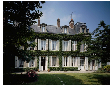
Élévation postérieure sur jardin. Phot. Fabrice Charrondière IVR22_19866000108VA
