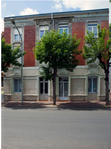
Vue générale. Phot. Pierre Thibaut IVR31_20146202195NUCA
