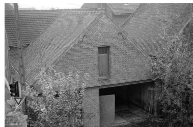
Dépendance à usage de garage. Phot. Bertrand Fournier IVR22_19996001446Z
