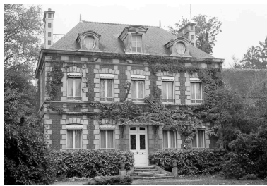
Maison patronale : façade antérieure. Phot. Bertrand Fournier IVR22_19996001449Z
