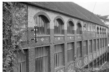
Atelier de fabrication, façade est, vue vers le nord. Phot. Bertrand Fournier IVR22_19996001453Z
