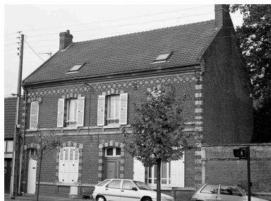
Bureaux : façade sur rue. Phot. Bertrand Fournier IVR22_19996001448Z
