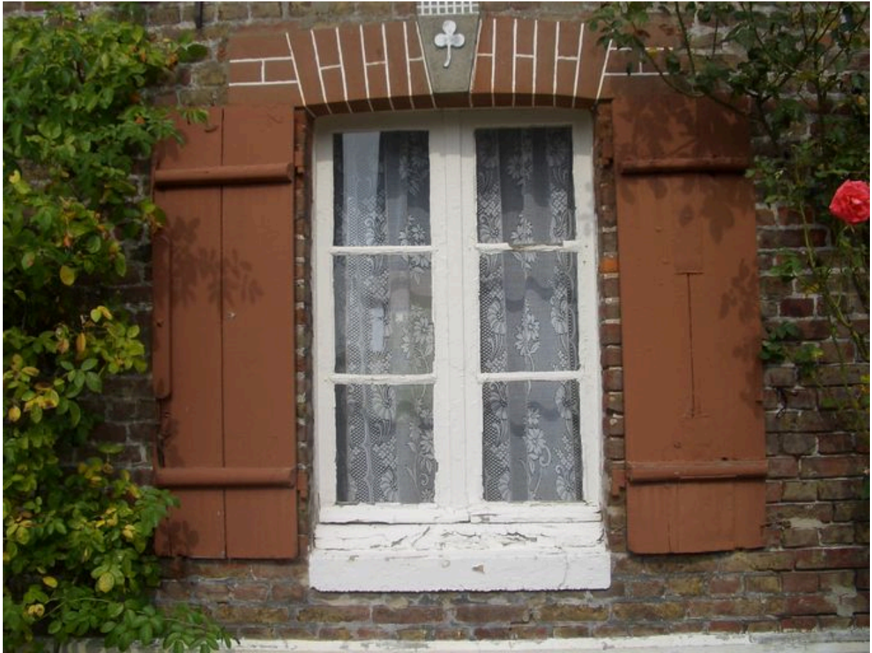
Vue détaillée d'un contrevent.
