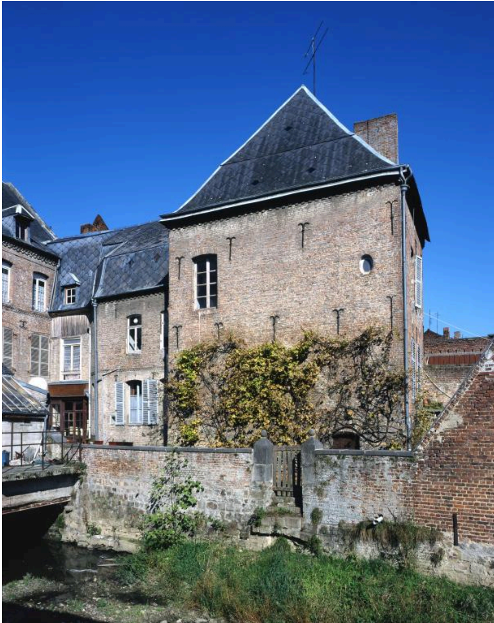
Vue de la cour arrière de la maison, avec le second logis en bordure du canal de la Filature.
