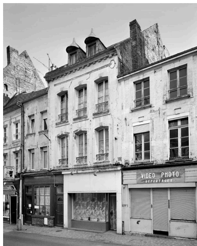
Vue de la façade sur rue. Phot. Thierry Lefébure IVR22_20020200829V
