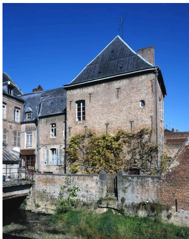
Vue de la cour arrière de la maison, avec le second logis en bordure du canal de la Filature. Phot. Marie-Laure Monnehay-Vulliet IVR22_19990205959VA
