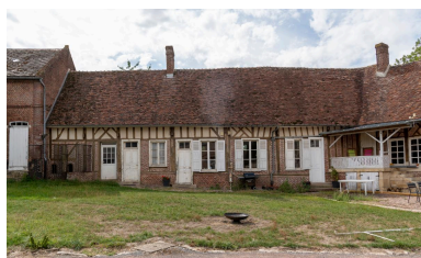
Ancien logement des bonnes, bûcher, poulains, vue depuis le nord. Phot. Marc Kérignard IVR32_20226000938NUCA
