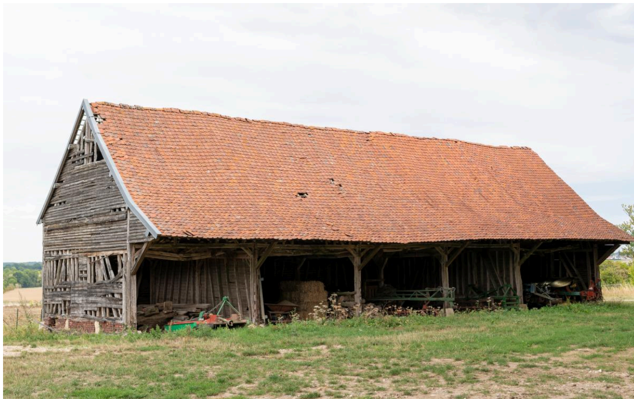
Ancien hangar agricole, vue depuis le sud-ouest.
