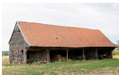
Ancien hangar agricole, vue depuis le sud-ouest. Phot. Marc Kérignard IVR32_20226000911NUCA
