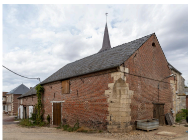
Anciennes étables et emplacement de l'ancien porche (départ d'arc dans l'angle du bâtiment). Phot. Marc Kérignard IVR32_20226000913NUCA
