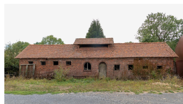
Anciennes porcheries, vue depuis le nord. Phot. Marc Kérignard IVR32_20226000912NUCA
