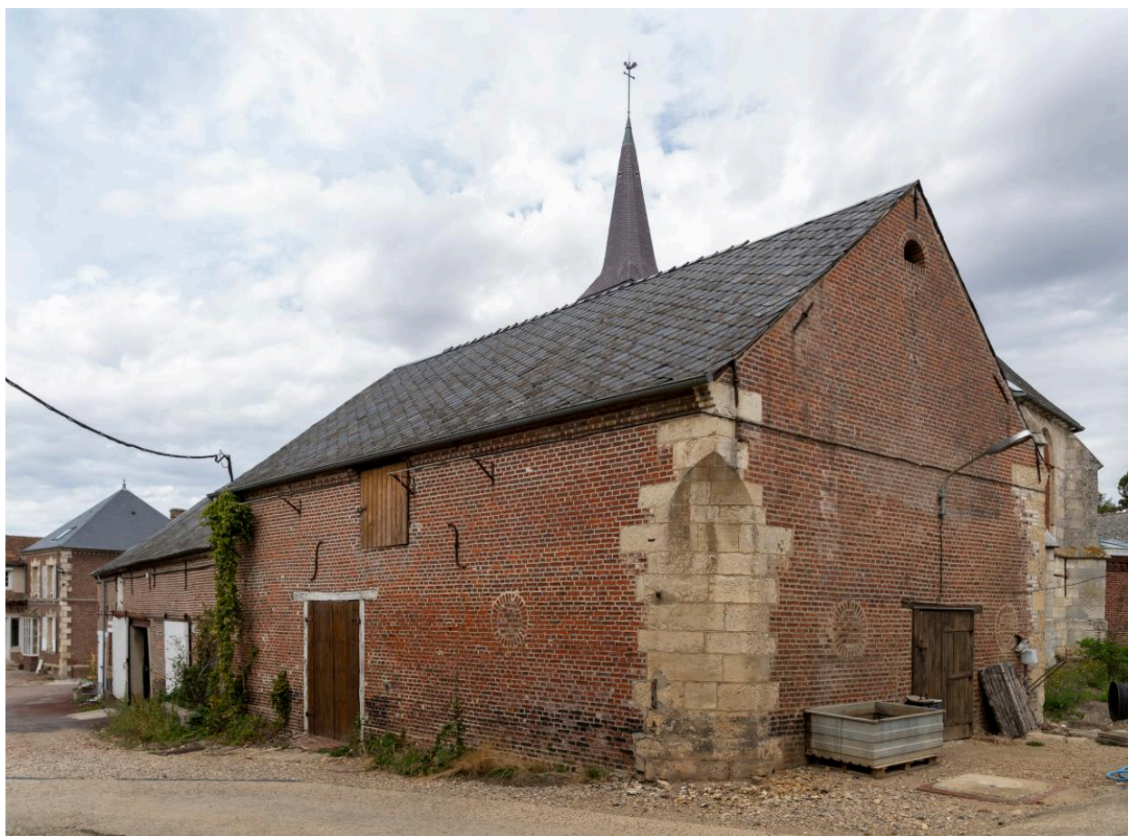
Anciennes étables et emplacement de l'ancien porche (départ d'arc dans l'angle du bâtiment).
