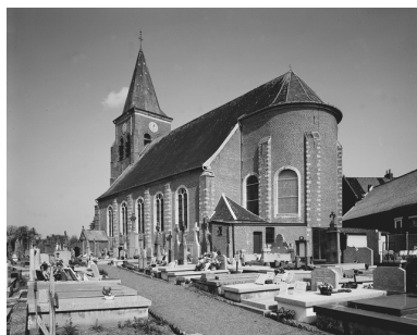
Vue générale extérieure, depuis le cimetière. Phot. Philippe Dapvril IVR31_20045900151V
