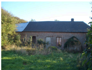
Vue postérieure du logis avec four à pain.
