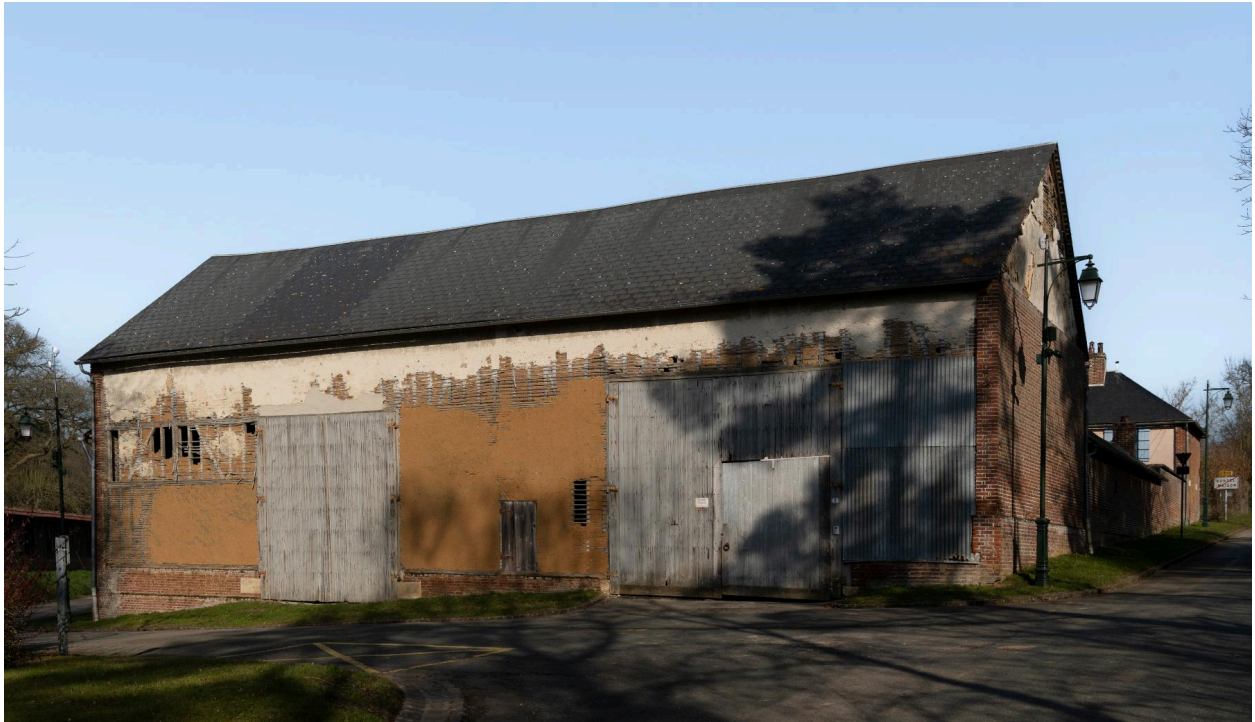
Grange de la ferme au n°9 de la rue du Presbytère, vue prise depuis le sud.
