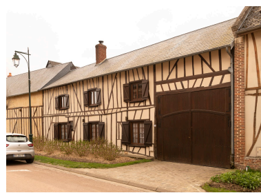
Logis sur rue avec entrée charretière, n°32 de la Neuve-Rue, vue prise depuis le nord.
