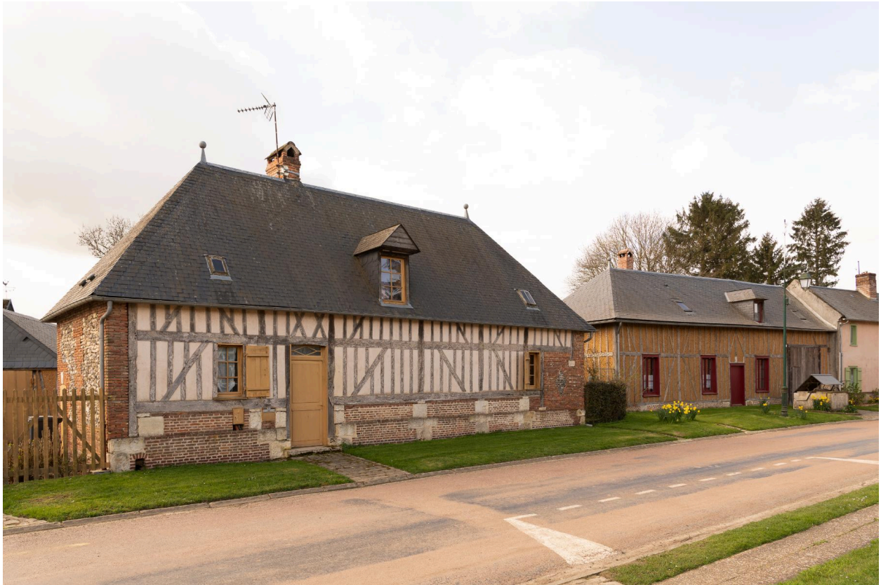
Logis sur rue, n°18bis de la Neuve-Rue, vue prise depuis le nord.
