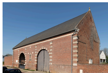
Foyer Saint-Nicolas (ancienne ferme), n°35 de la Neuve-Rue, vue prise depuis le sud.
