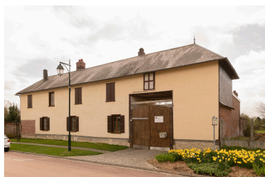
Logis sur rue avec entrée charretière, n°46 de la Neuve-Rue, vue prise depuis le nord. Phot. Marc Kérignard IVR32_20236000304NUCA
