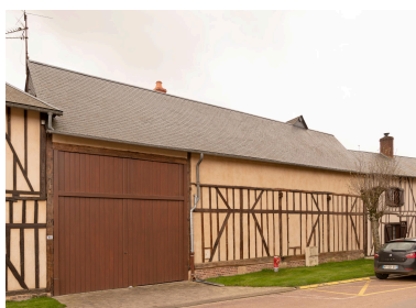
Grange sur rue, n°30 de la Neuve-Rue, vue prise depuis le nord.
