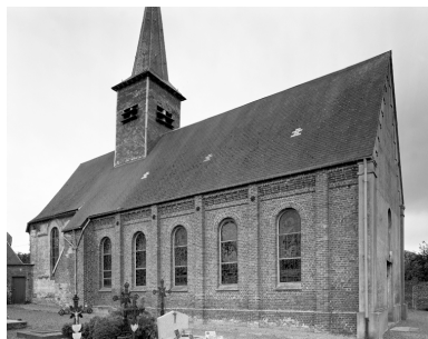
L'église vue du nord-ouest. Phot. Thierry Lefébure IVR22_19910200808V
