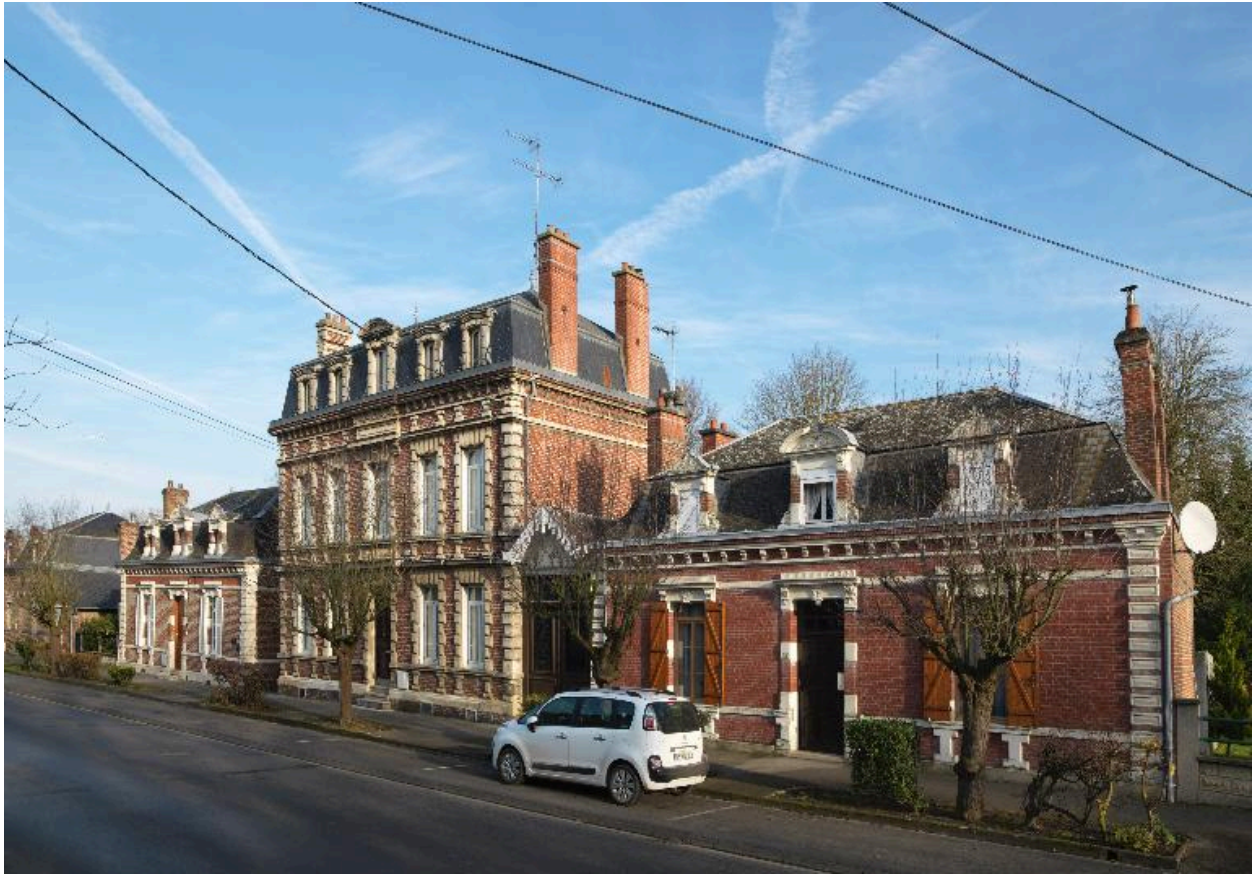
Hôtel et maisons de rapport, 25 à 29 boulevard de la République. Vue générale, depuis le sud-est.
