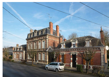
Hôtel et maisons de rapport, 25 à 29 boulevard de la République. Vue générale, depuis le sud-est. Phot. Marie-Laure Monnehay-Vulliet IVR22_20158001065NUC2A
