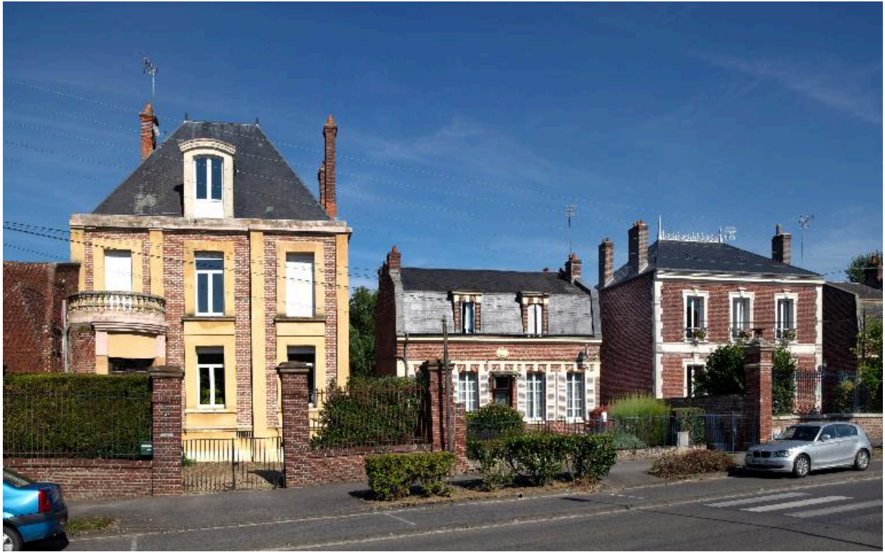
Hôtel et maisons, face à la place Peltier. Au centre la maison Debeauvais-Guilbert, à droite l'ancienne villa Beauséjour.
