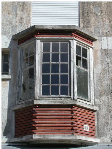
Détail d'un bow-window. Phot. Elisabeth Justome IVR22_20058002715NUCA
