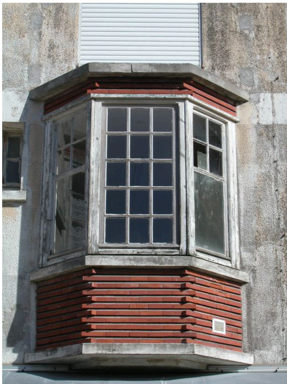
Détail d'un bow-window.
