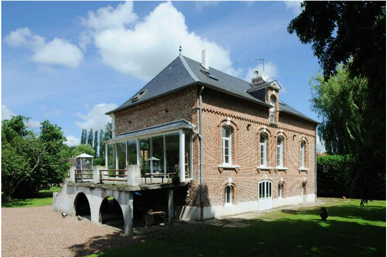
Façade sur jardin, vue de trois-quarts.
