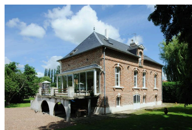
Façade sur jardin, vue de trois-quarts. Phot. Thierry Lefébure IVR22_20128000315NUC2A
