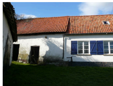
Vue de l'écurie dans le prolongement du logis. Phot. Inès Guérin IVR22_20078005624NUCA
