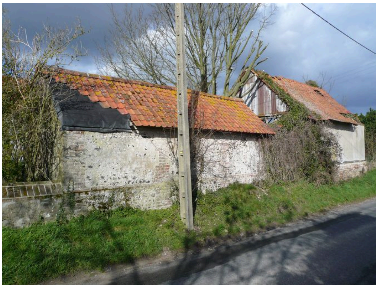
Vue des bâtiments sur rue.
