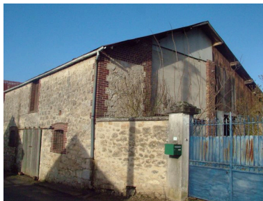
Vue des dépendances. Phot. Inès Guérin IVR22_20050200394NUCA
