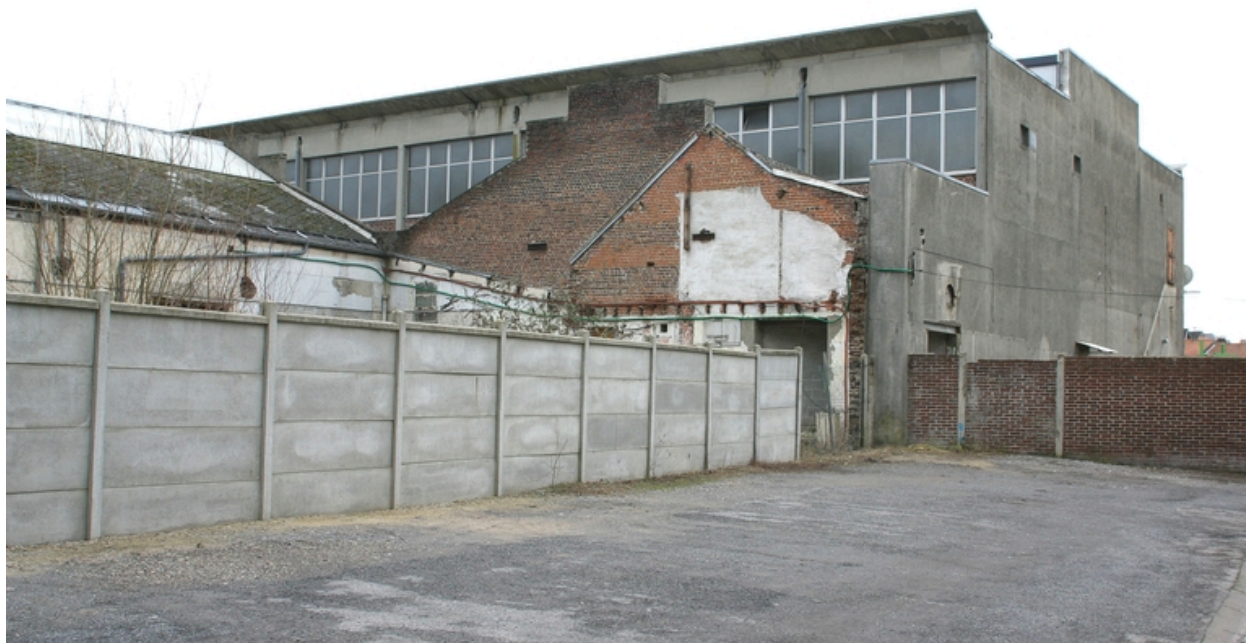
Façade postérieure des ateliers de 1950.
