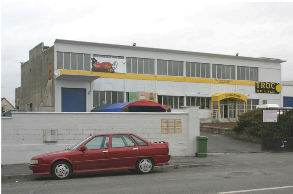
Façade antérieure des ateliers de 1950.
