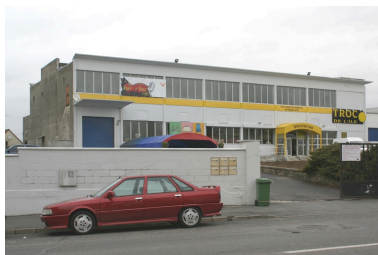
Façade antérieure des ateliers de 1950.
