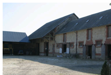
Vue de l'étable située sur le côté sud de la propriété. Phot. Inès Guérin IVR22_20050200886NUCA
