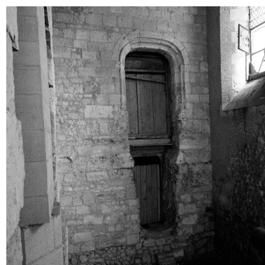
Porte donnant accès à la cathédrale, depuis le collatéral sud de la Basse-Oeuvre. Phot. Thierry Lefébure IVR22_19996001752X
