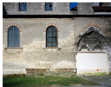
Vue du flanc sud. Phot. Thierry Lefébure IVR22_20006000312VA
