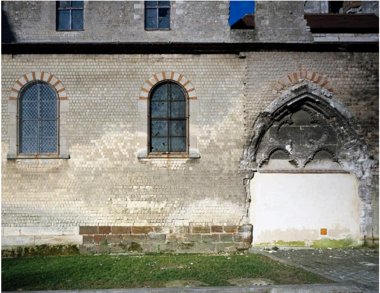
Vue du flanc sud.
