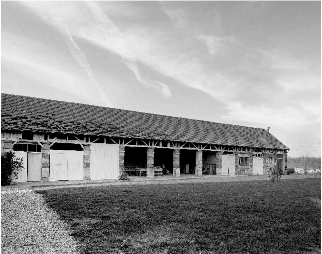
Élévation sur cour des remises.
