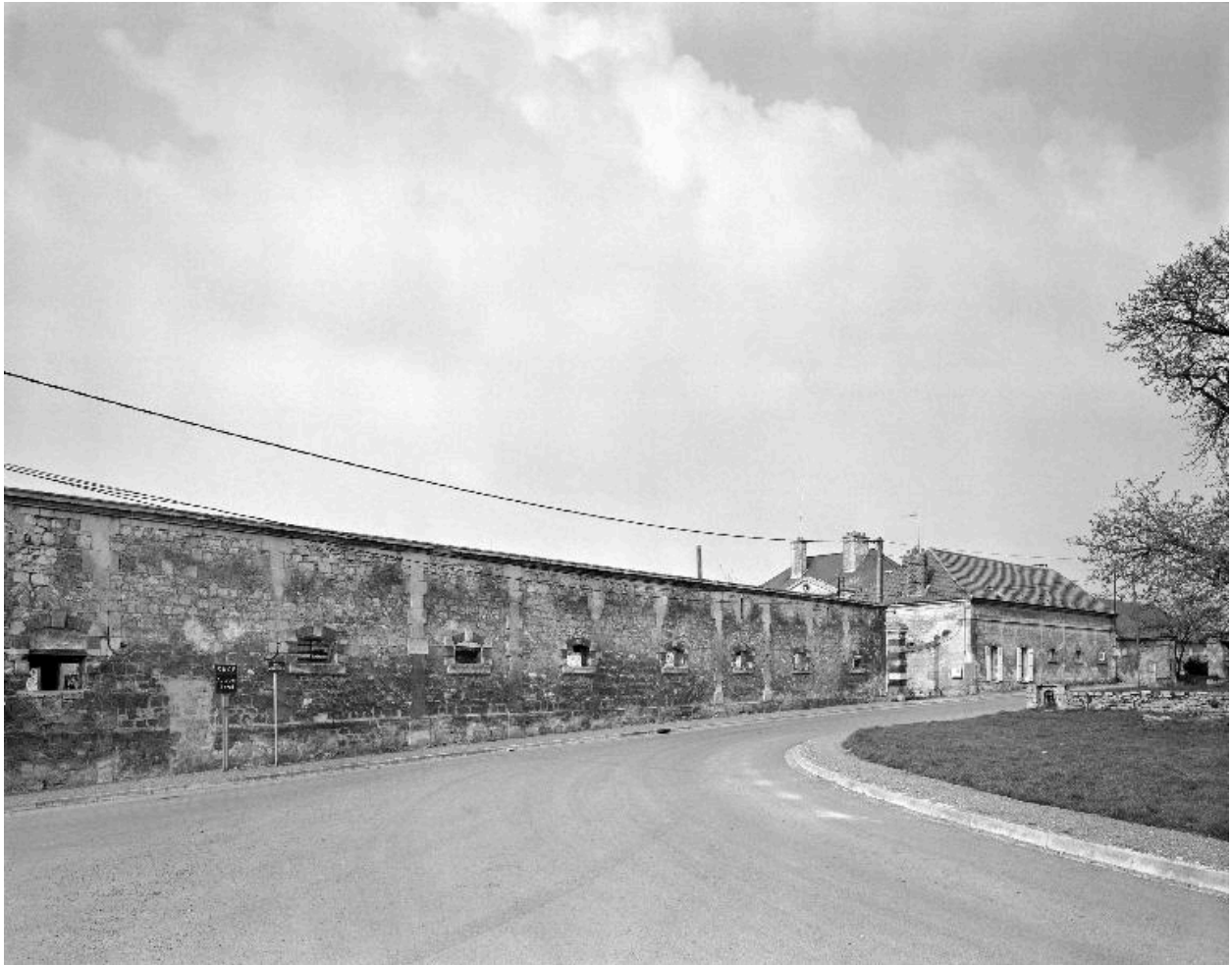
Élévation sur rue des bâtiments agricoles sud.
