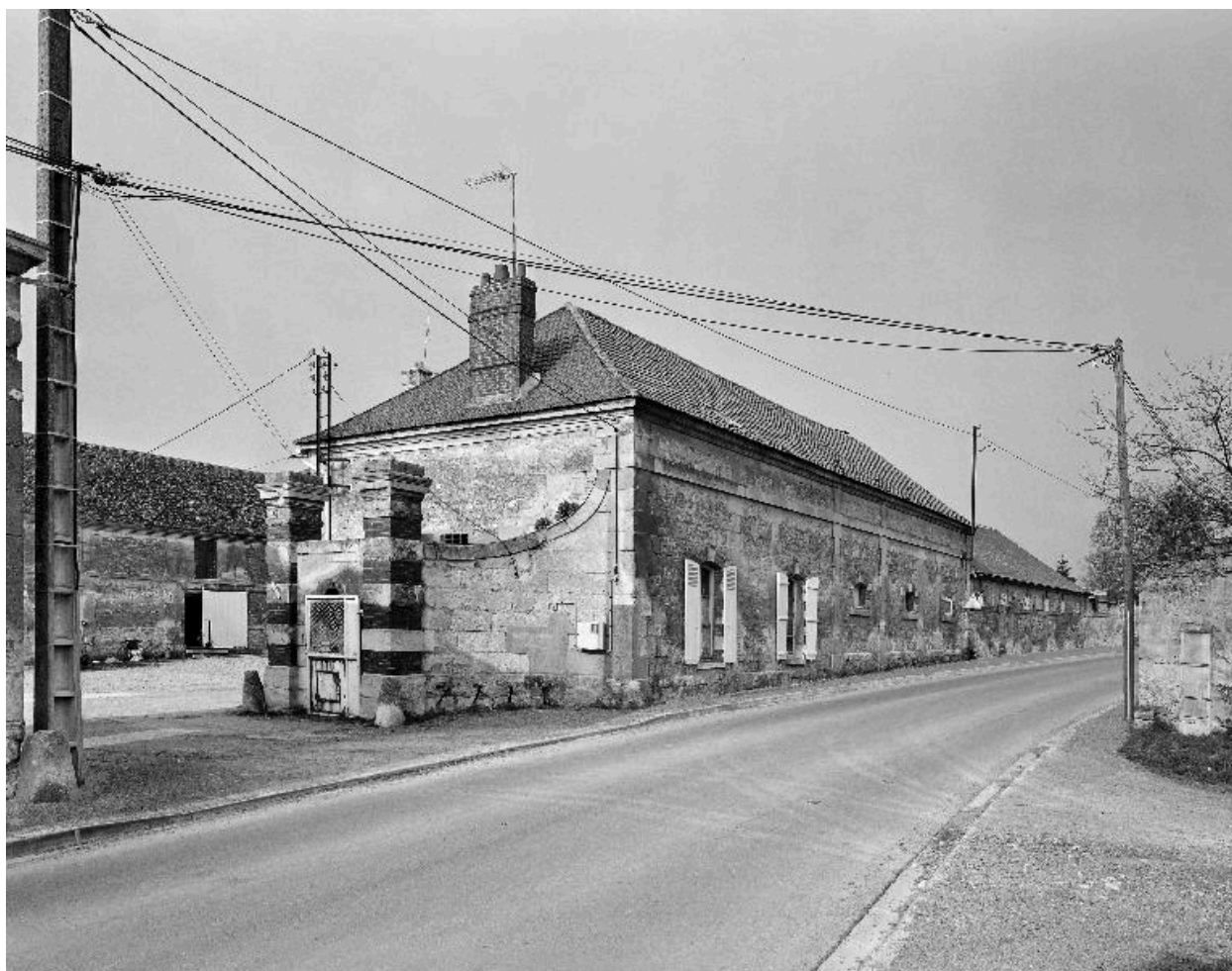
Élévation sur rue du portail d'entrée et des bâtiments sud-est.
