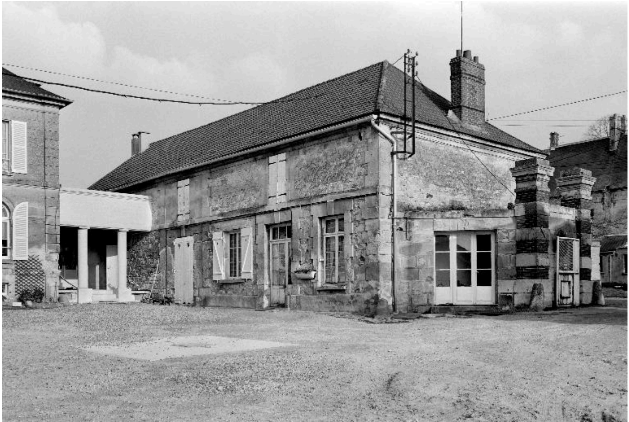
Élévation sur cour des bâtiments sud-est.
