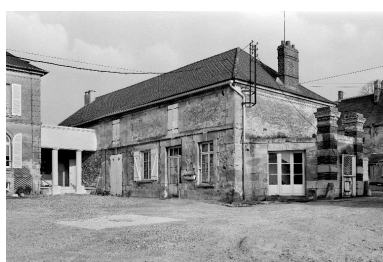
Élévation sur cour des bâtiments sud-est. Phot. Thierry Lefébure IVR22_19900200647X
