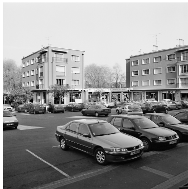
Vue générale de l'immeuble Lalo et vue partielle de l'immeuble Bizet.
