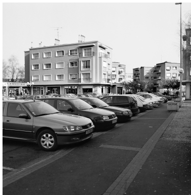
Vue générale de l'immeuble Bizet et perspective sur la rue des Arts.
