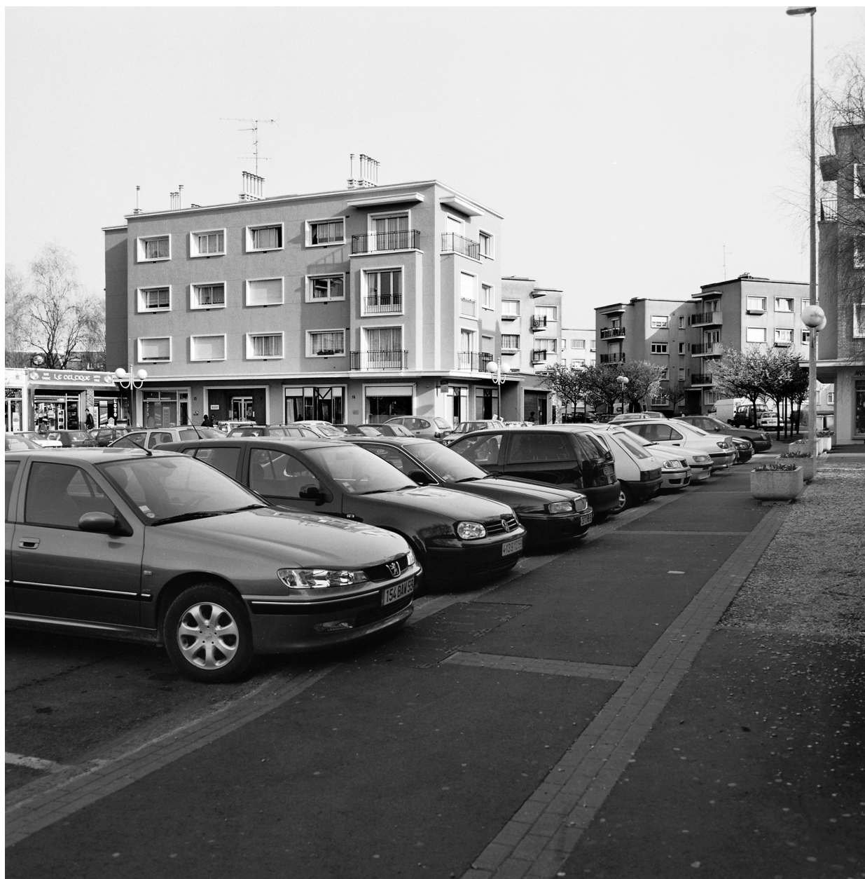
Vue générale de l'immeuble Bizet et perspective sur la rue des Arts.
