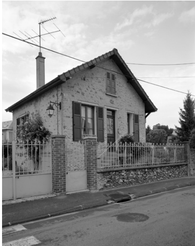
Vue de la façade sur la rue. Phot. Thierry Lefébure IVR22_19960200513V
