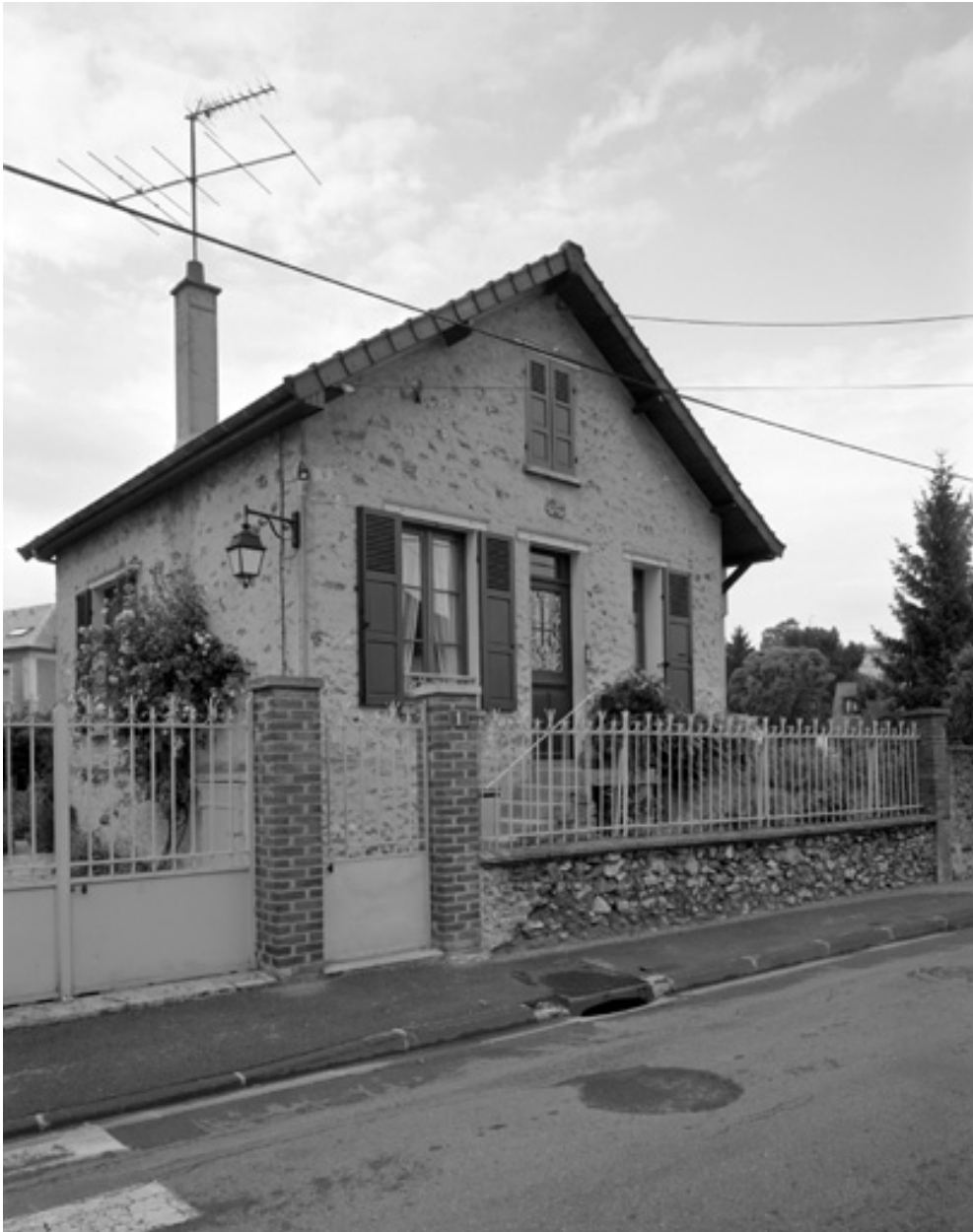
Vue de la façade sur la rue.
